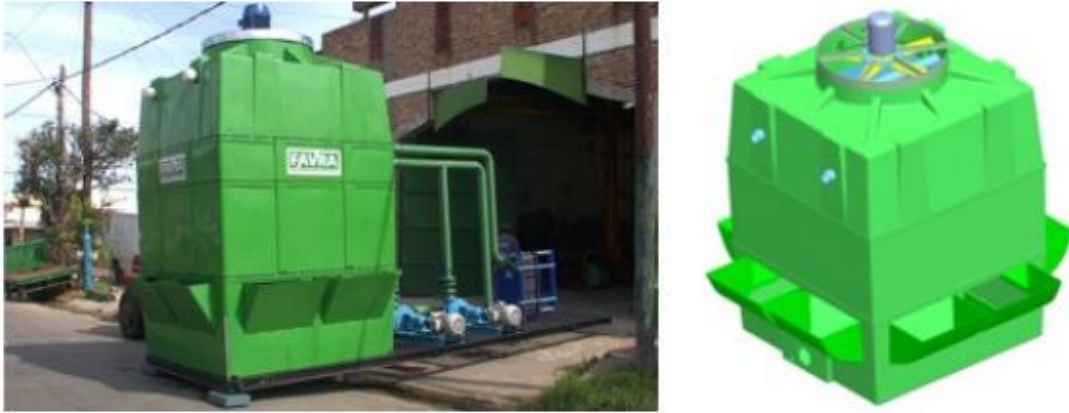
Figura 9-7. Torre de enfriamiento adoptada.
