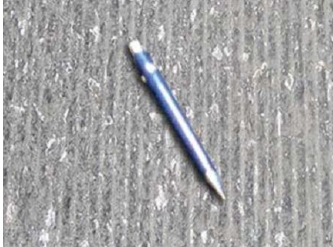
Figura 2-11. Fresado fino Fuente: Bonfim, 2008
