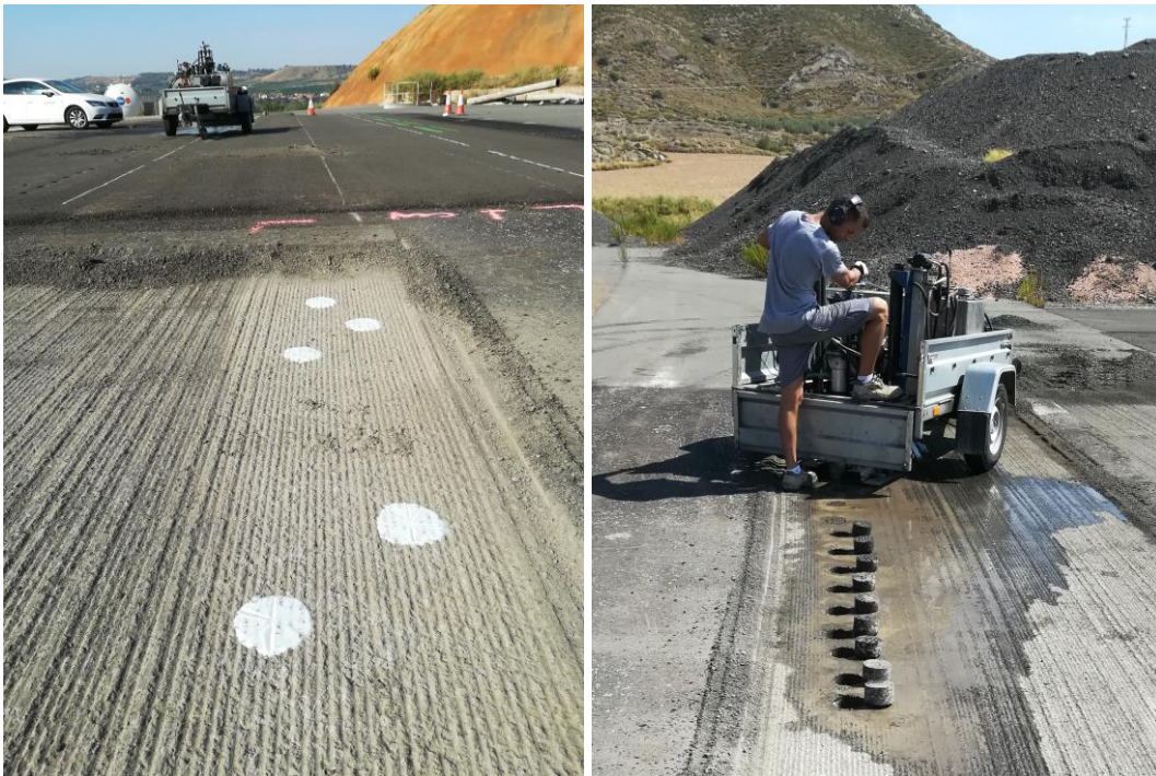
Figura 7-28. Medición de Parche de Arena y extracción de testigos en el tramo en estudio
