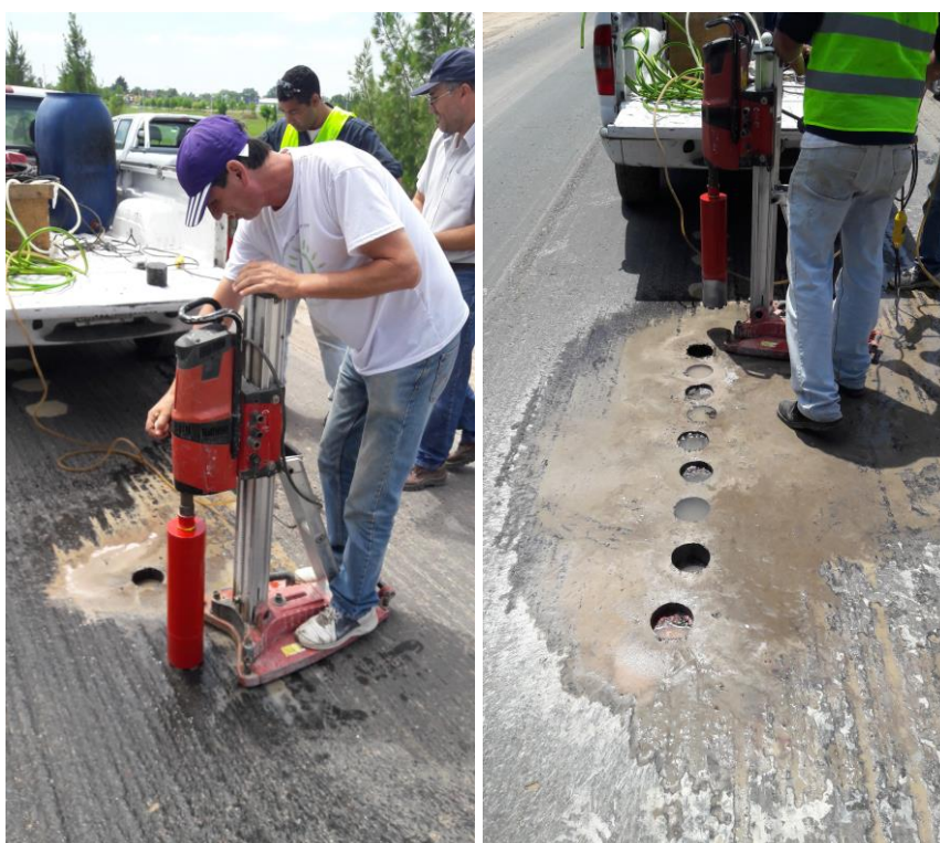
Figura 7-10. Extracción de testigos en el sector en análisis Fuente: elaboración propia
