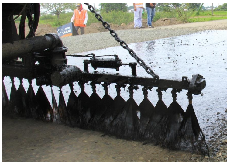
Figura 2-2. Aplicación de un riego de liga Fuente: revistazonalibre.com
