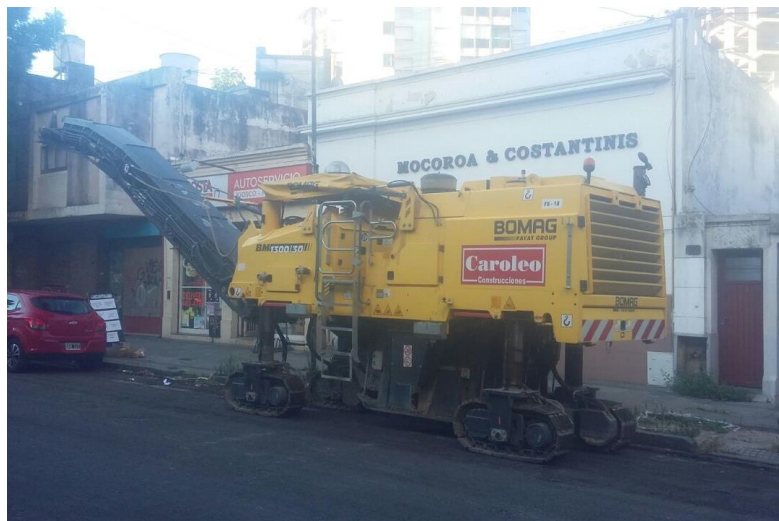
Figura 4-10. Equipo de fresado empleado en la Obra A en estudio Fuente: elaboración propia
