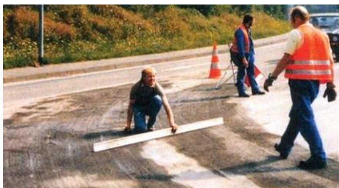
Figura 2-16. Fresado de regulación de una vía Fuente: Bonfim, 2008
