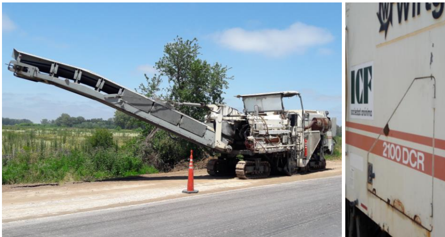
Figura 7-5. Equipo de fresado utilizado en la obra Fuente: elaboración propia
