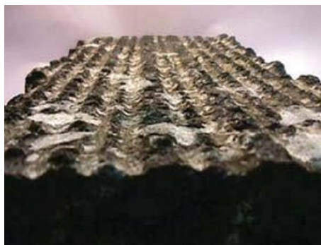
Figura 2-9. Corte de una superficie fresada en frío Fuente: Bonfim, 2008
