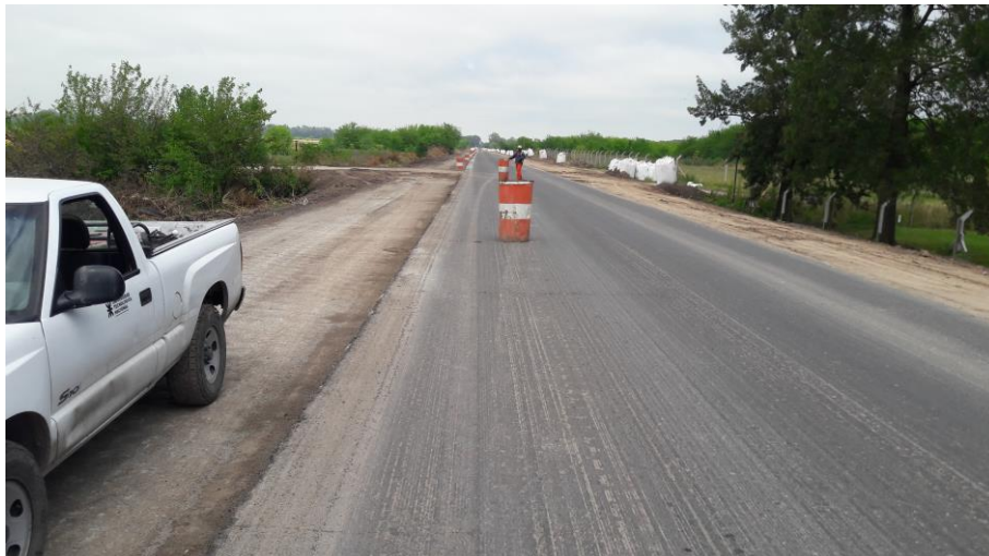
Figura 7-3. Vista general del sector analizado Fuente: elaboración propia
