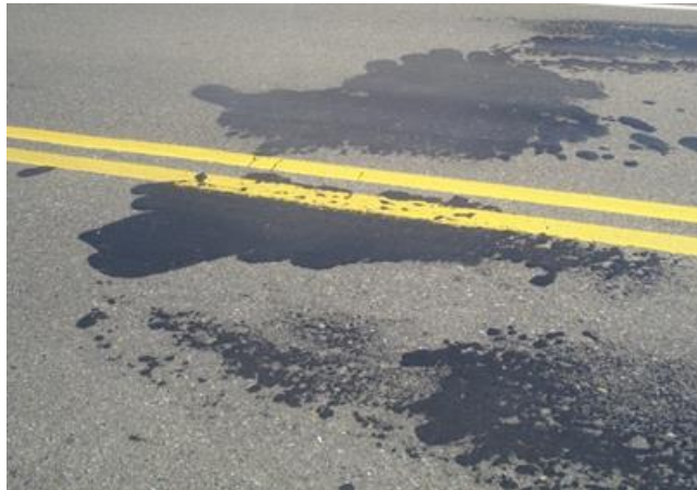
Figura 2-22. Superficie con exudación Fuente: Bianchetto, 2012
