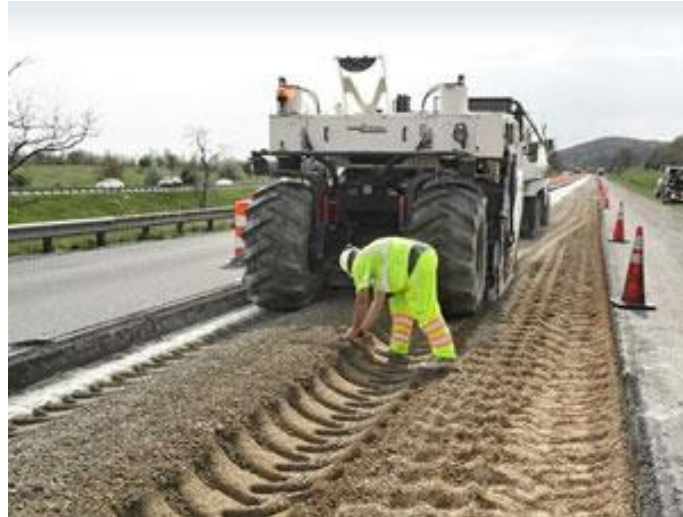
Figura 2-19. Reciclado de un pavimento Fuente: www.britishlime.org
