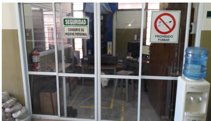
Figura 3-20. Ambiente de ensayo climatizado empleado Fuente: elaboración propia
