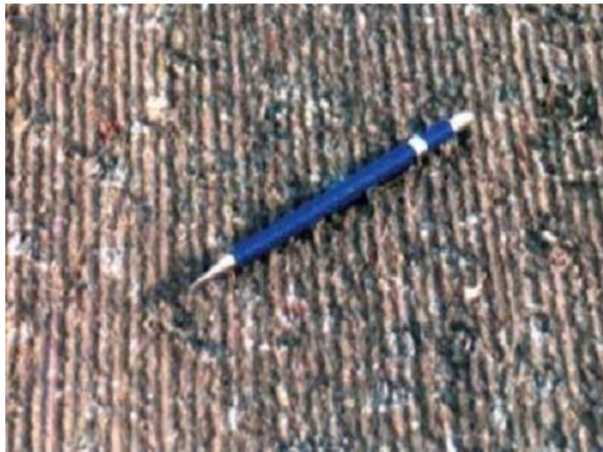
Figura 2-12. Microfresado Fuente: Bonfim, 2008
