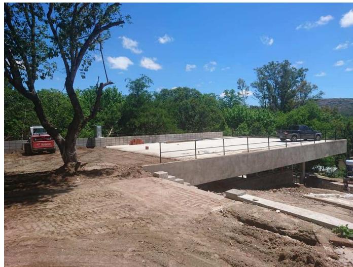
Figura 22: Techo del Sum.
