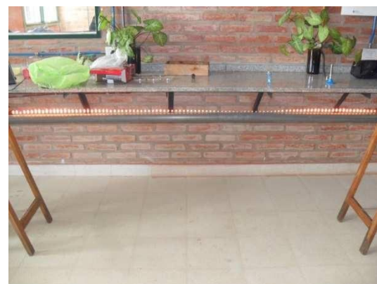
Foto N°4: Apreciación de la superficie total perforada.
