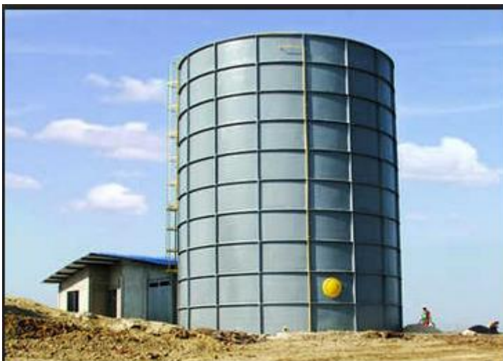
Tanques para Almacenamiento de Agua Potable
