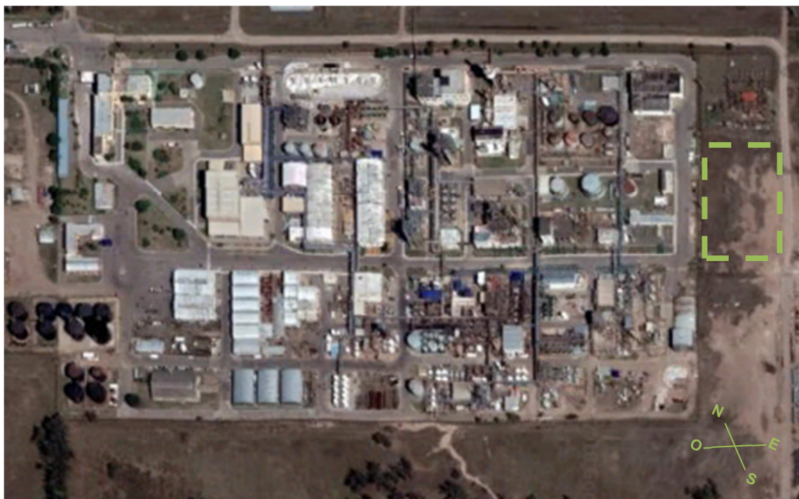
Figura 12-2. Terreno seleccionado para construir la planta de policloruro de aluminio (Fuente: Google Earth)
