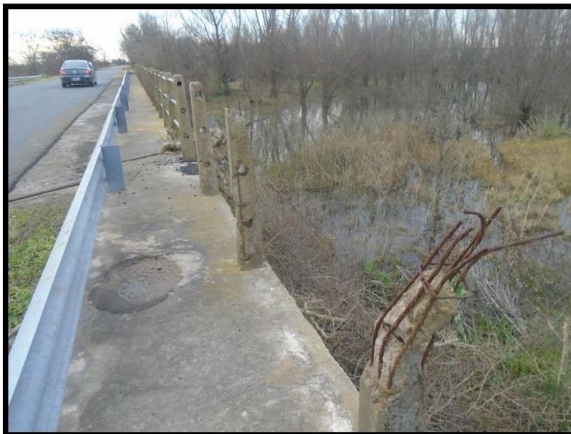
Foto 10: Puentes en el tramo de la obra que serán acondicionados
