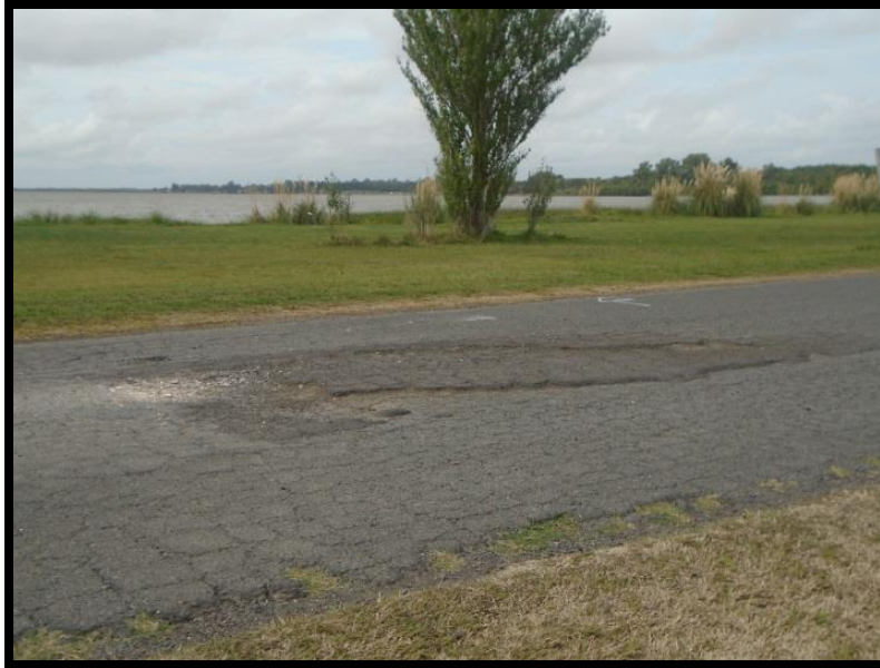
Foto 8: Escarificado de la superficie
