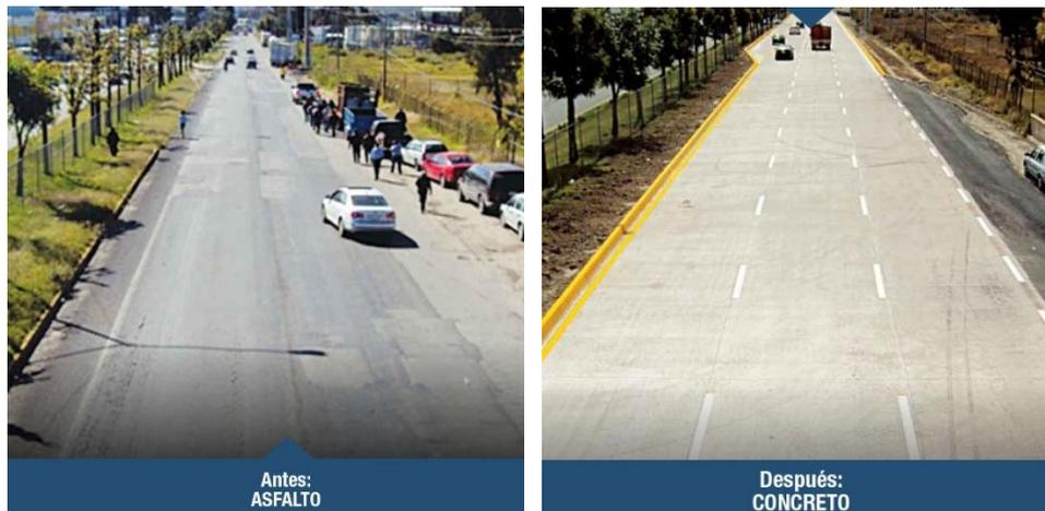
*Figura 7-20 | Vía antes y después de la aplicación de whitetopping.*
