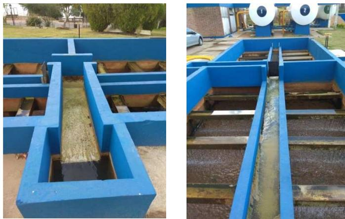
Ilustración 35. Filtro a cielo abierto. Vistas laterales.
