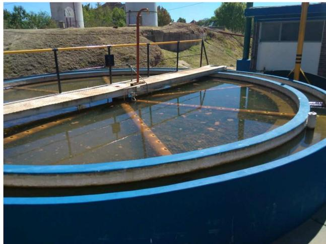
**Ilustración 25. Sedimentador de la planta "A" de la planta de tratamiento actual.**
