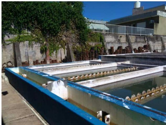
Ilustración 29. Sedimentador de la planta "B" de la planta actual. Vista lateral.
