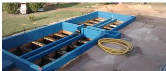
Ilustración 36. Vista superior. Filtro a cielo abierto.
