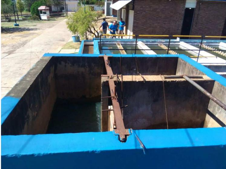
Ilustración 31. Sedimentador de la planta "B" de la planta actual. Vista de arriba.
