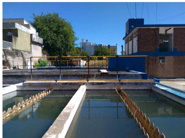
Ilustración 30. Sedimentador de la planta "B" de la planta actual. Vista frontal.
