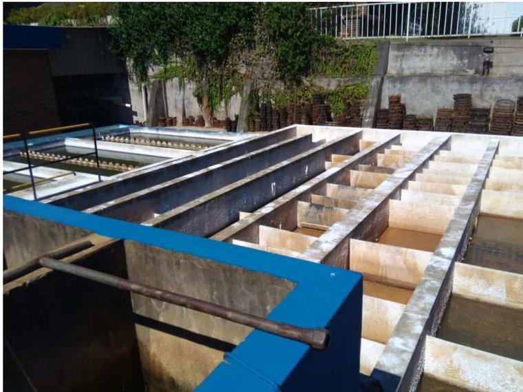
Ilustración 32. Sedimentador de la planta "B" de la planta actual. Vista de arriba.
