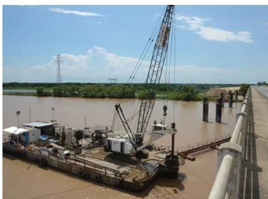
Foto N° 7: Piloteadora sobre plataforma flotante. Fuente: gentileza Ing. Civil Sandro Balzani
