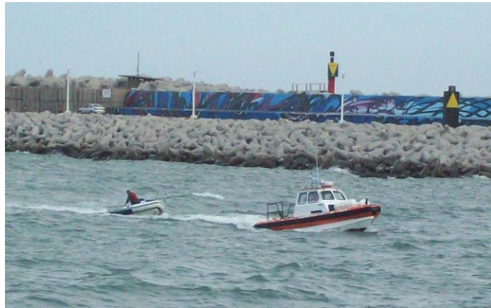
Foto N° 17: Vista de la cara norte de la escollera sur. Fuente: https://prensanecochea.wordpress.com
