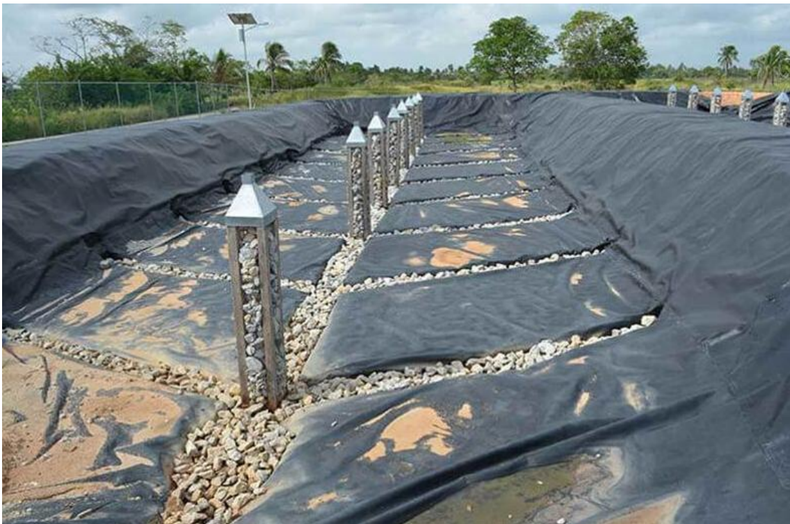
Figura 3. Construcción y armado de chimeneas para extracción de gases y líquidos
