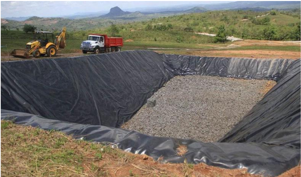
Figura 4. Relleno de una Trinchera
