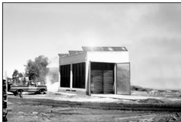
FIGURA 4. Vista general del prototipo de secadero solar terminado.
