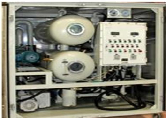
Una vez recirculado la totalidad del aceite contenido en el transformador y mediante chequeos de campo de las características generales del aceite y si este está dentro de los valores de norma, se procede a iniciar el proceso de tensionado de prueba, chequeos eléctricos y después de horas de tensionado y prueba esta máquina es liberada al servicio de explotación.
