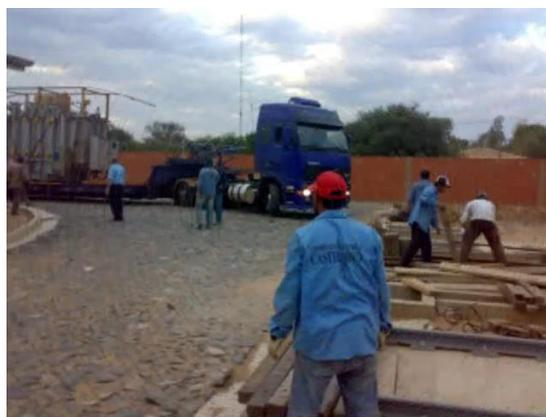
Una vez llegado a la Estación Transformadora, el vehículo posiciona el carretón con su carga de manera que esta quede frente a la futura posición. Obsérvese que el transformador es montado en una posición que favorece a su transportado y su nueva posición de montaje y servicio.
