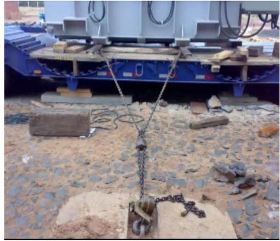
Posicionado el carretón, se procede a montar los durmientes de madera, rieles por donde se deslizará el transformador sobre sus patines. También se posicionan los aparejos para envío y reenvío y los malacates para realizar los tiros.
