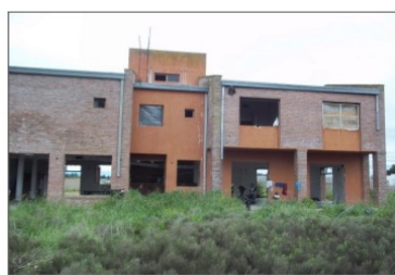
CONTRAFRENTE SITUACION ACTUAL
