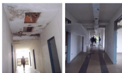
SITUACION ACTUAL HALL DE ACCESO
