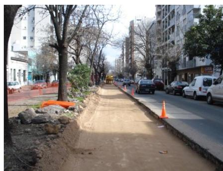
**Figura 3** Ejecución de sub base de suelo seleccionado
