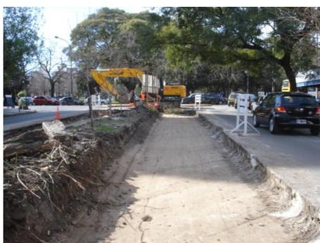
**Figura 2** Apertura de caja, retiro de cordones graníticos y corrección de subrasante con cal
