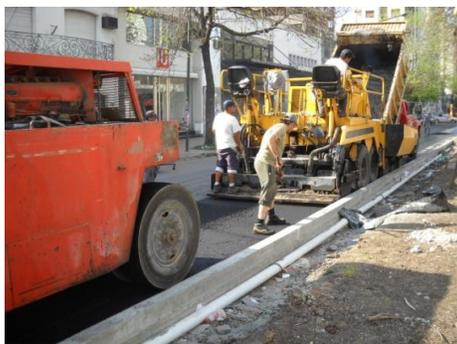
Figura 6 Colocación y compactación del asfalto
