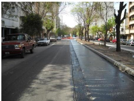
**Figura 4** Fresado y aplicación de riego de liga
