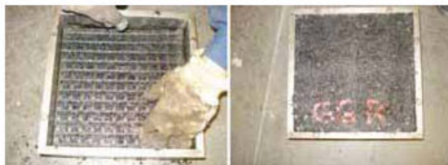
Fotografía Nº 8: Colocación de la Geogrilla de fibra de vidrio
