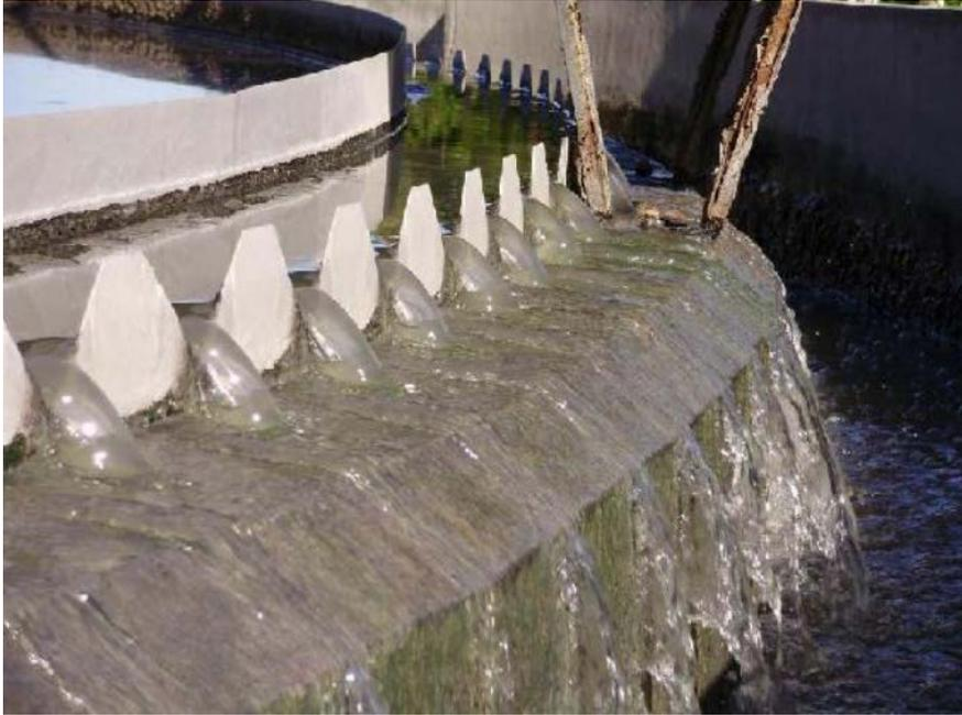
Imagen 9-5: Vertedero de Decantador Primario.
