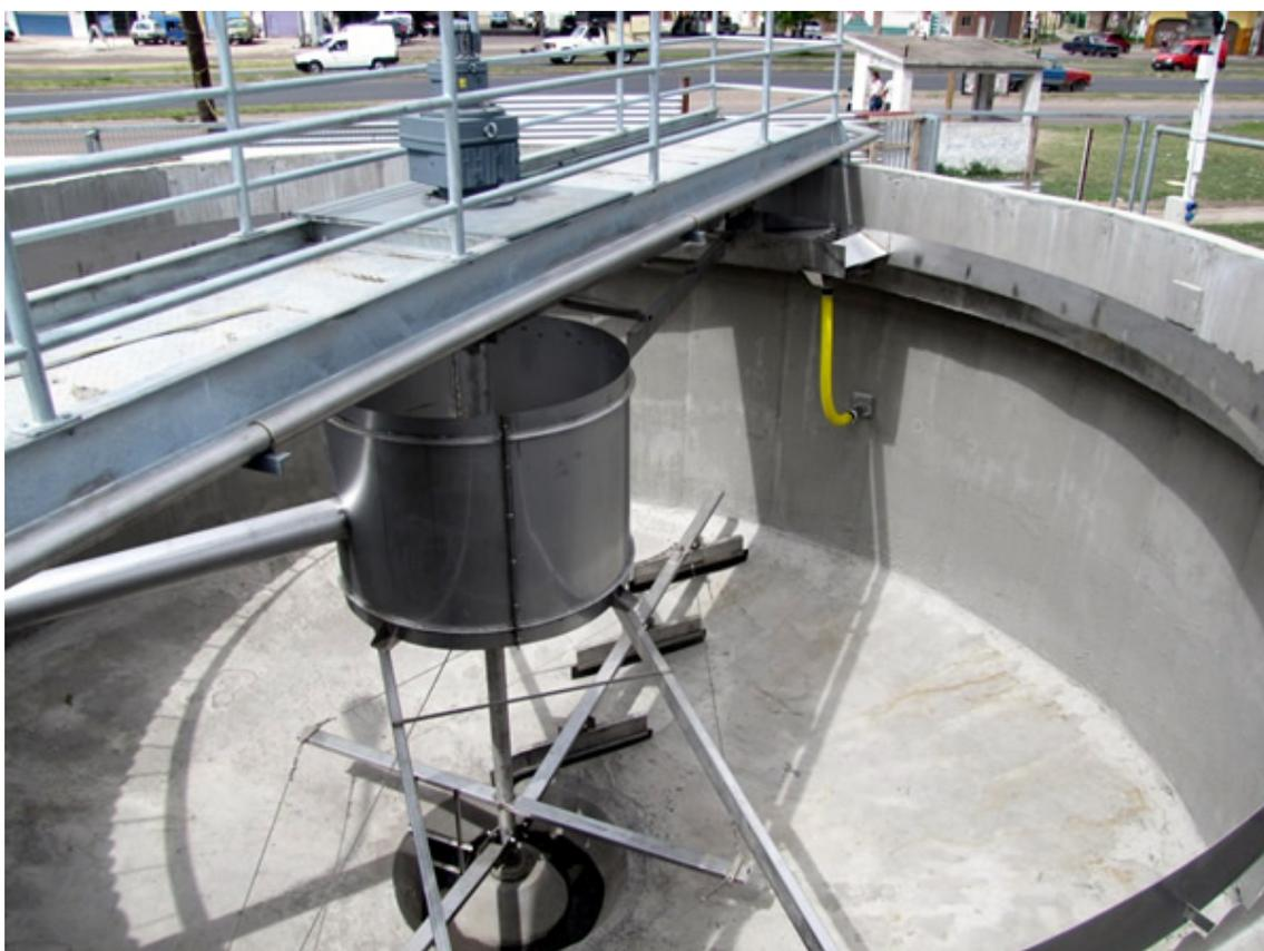
Imagen 12-19: Sedimentador Primario con barreadores de fondo, con vertederos triangulares en todo el perímetro de chapa.
