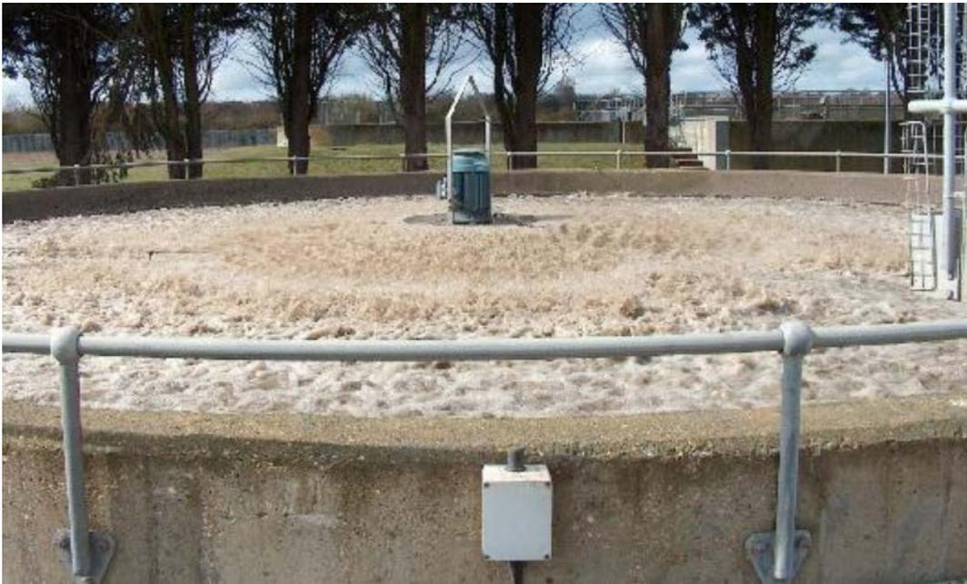
Imagen 9-7: Vista de Tanque Aireador Reactor Biológico.
