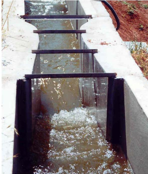
Imagen 12-15: Sección de control de una canaleta Parshall.
