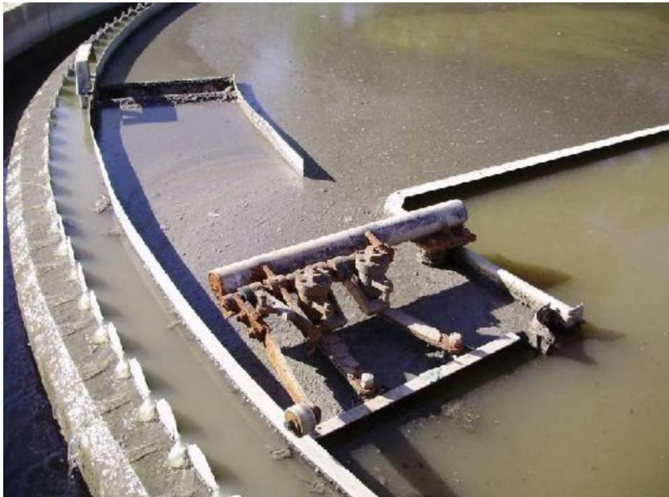
Imagen 9-4: Barredora de grasas de Decantador Primario.
