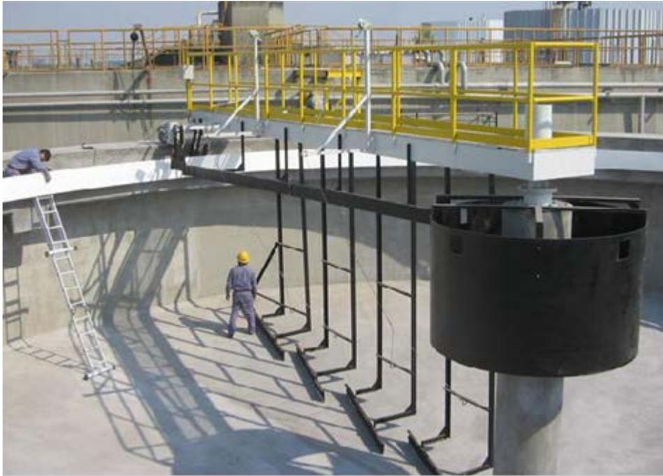
Imagen 9-3: Decantador Primario con barredoras de fondo.
