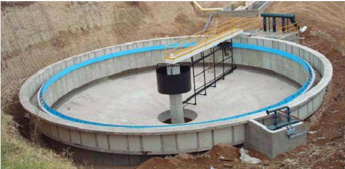
Imagen 9-2: Vista superior Sedimentador Primario.
