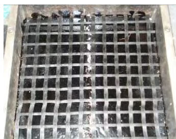
Figura VII.21 Colocación GR FV
