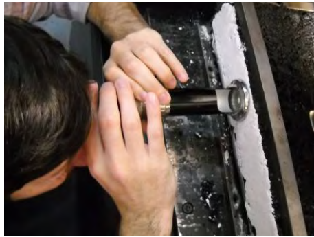
Figura VII.26 Seguimiento del progreso de las fisuras
