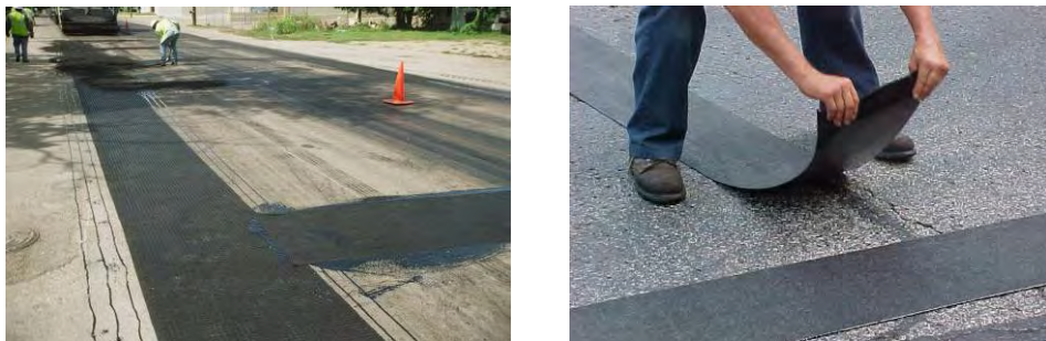
Figura V.32 Sistema de colocación localizado
