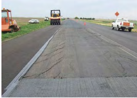
Figura V.46 Colocación defectuosa
