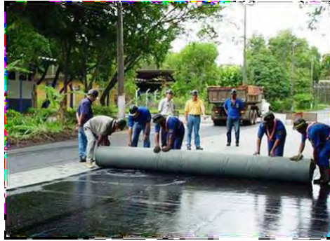
Figura V.37 Geotextil embebido en asfalto
