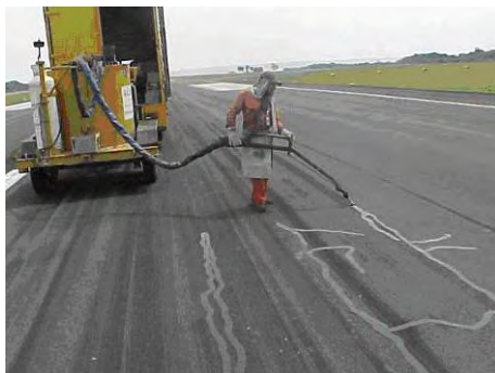
Figura V.35 Sellado de fisuras
