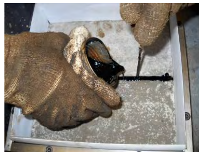
Figura VII.16 Placas de hormigón, sellado de junta
