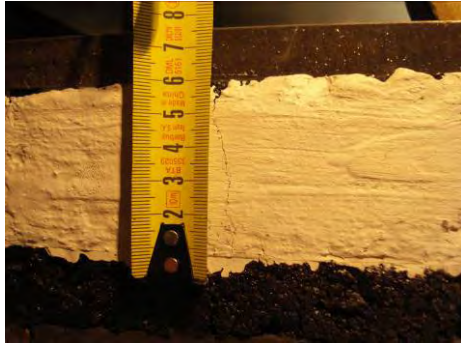
Figura VII.49 Propagación de fisura para la referencia de la investigación
