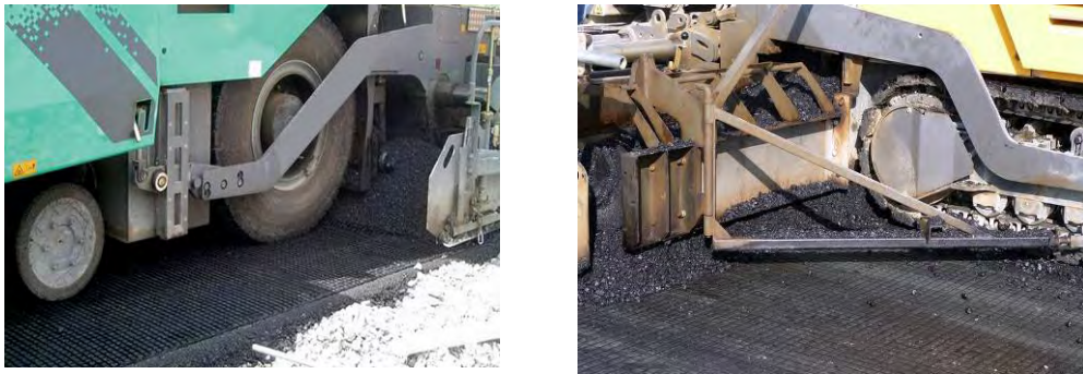
Figura V.11 Colocación en obra de mezcla asfáltica sobre el geosintético
