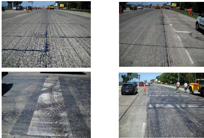
Figura A.1 Proceso constructivo en la Av. Lugones (Bs. As.)
