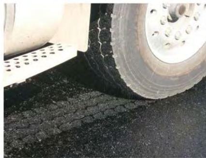
Figura IV.20 Riego termoadherente
