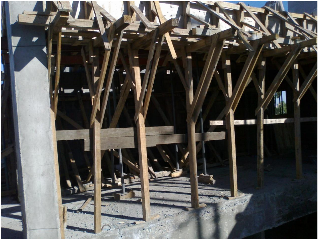
Apuntalamiento en vigas y losa.
