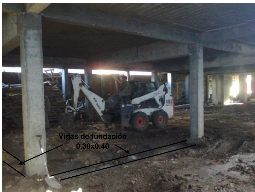
Inicio del zanjeo para vigas de fundación con martillo neumático.
