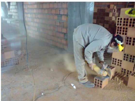
Utilización de herramientas portátiles: amoladora 9".
