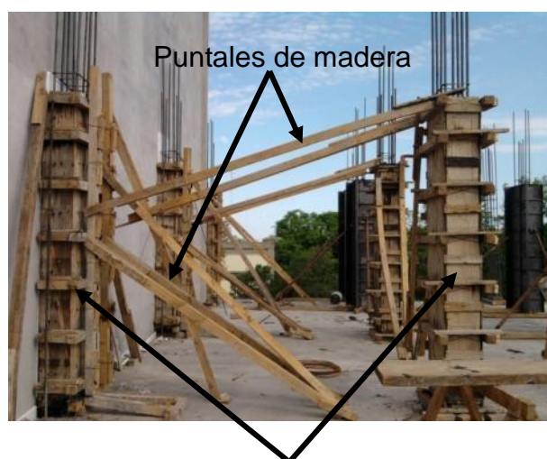
Encofrado de columnas
