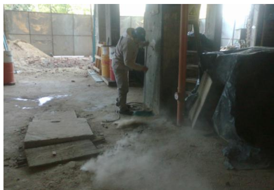
Inhalación de polvo: barrer el suelo de obra.
