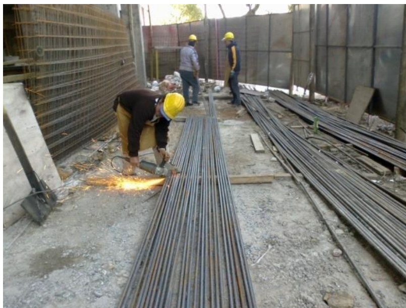
Corte de hierros para armado de vigas con amoladora.
