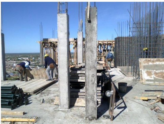
Levantamiento manual de cargas: preparación de encofrado de losa.
