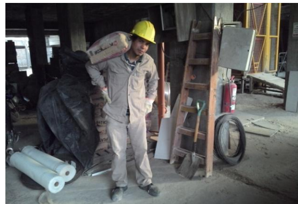
Levantamiento manual de cargas: movimiento de bolsas de cemento.
