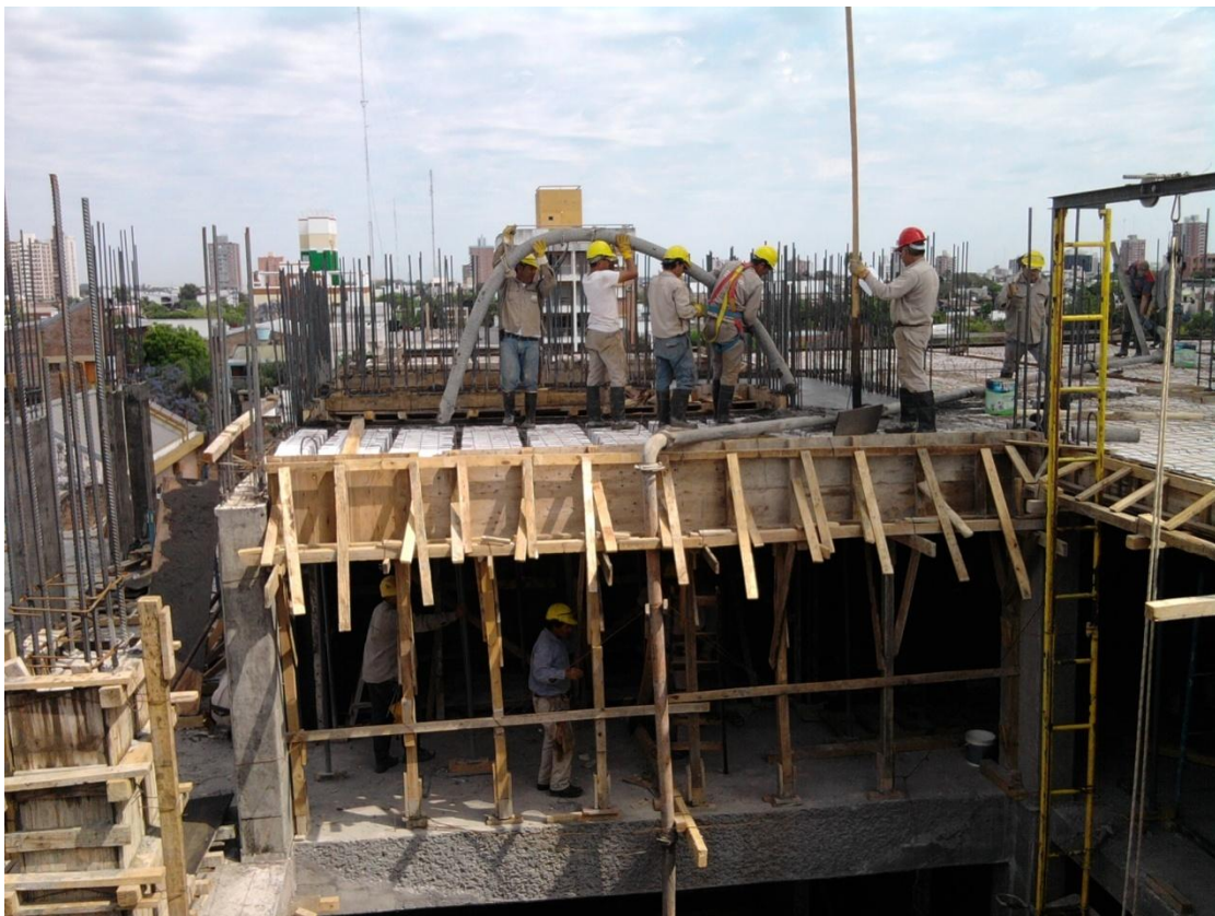
Apuntalamiento en vigas y losa.
