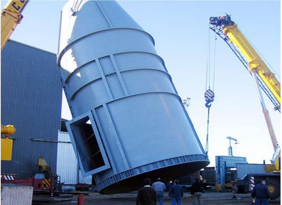
Fig 7: Montaje de chimenea construida por MANFERRO SA.
