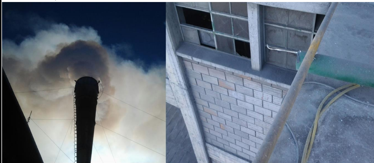
Fig. 42: Salida de las chimeneas vs salida filtro (Observar cinta testigo de teflón en la salida del filtro).
