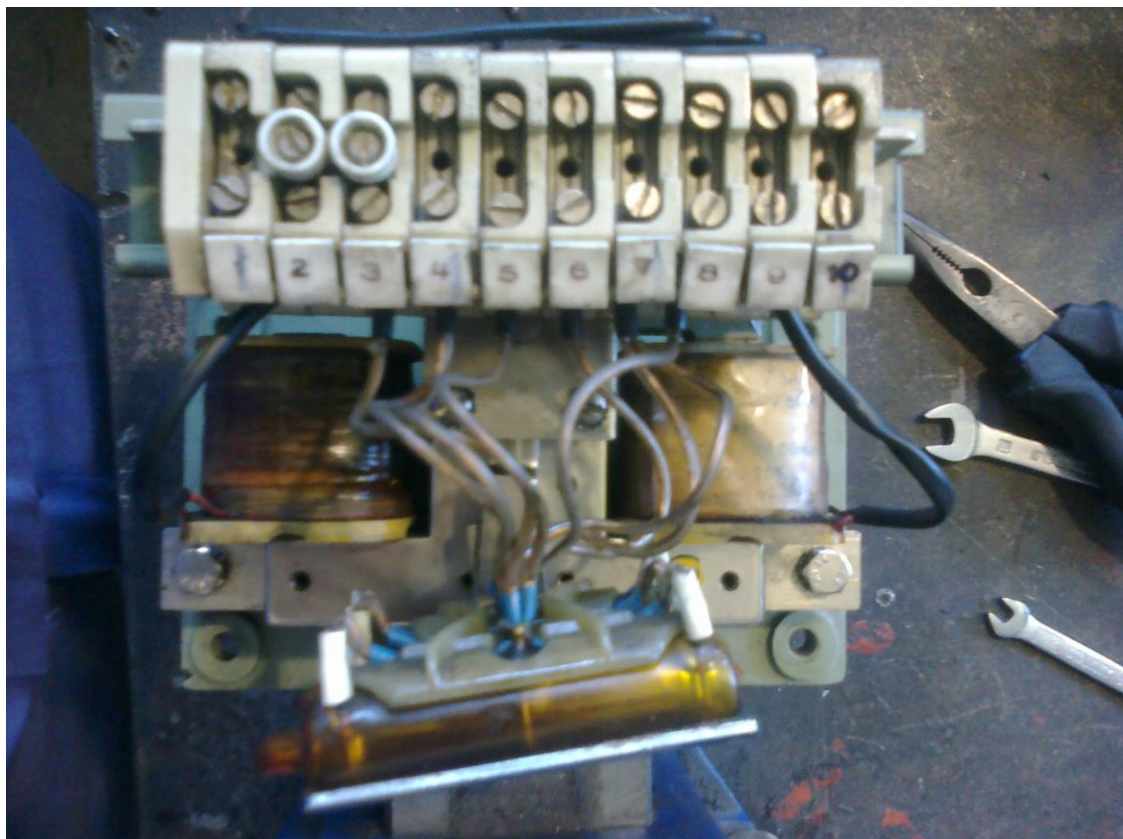
Fig. 54: Conmutador trafo T4 reparado, antes de ser colocado nuevamente.
