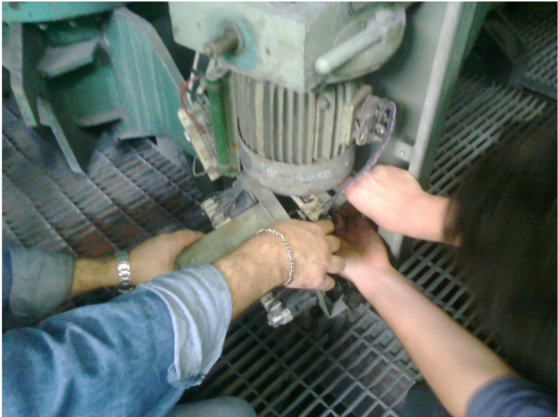
Fig. 53: Operarios electricistas extrayendo conmutador de trafo T4.
