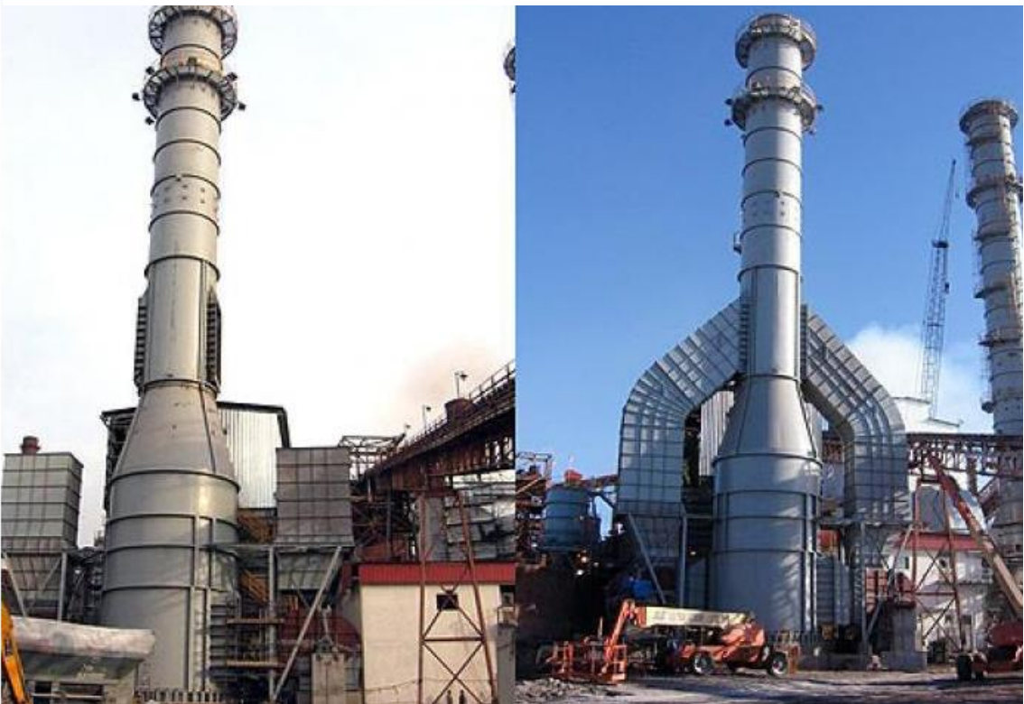
Fig. 8: Montaje definitivo de la chimenea.
