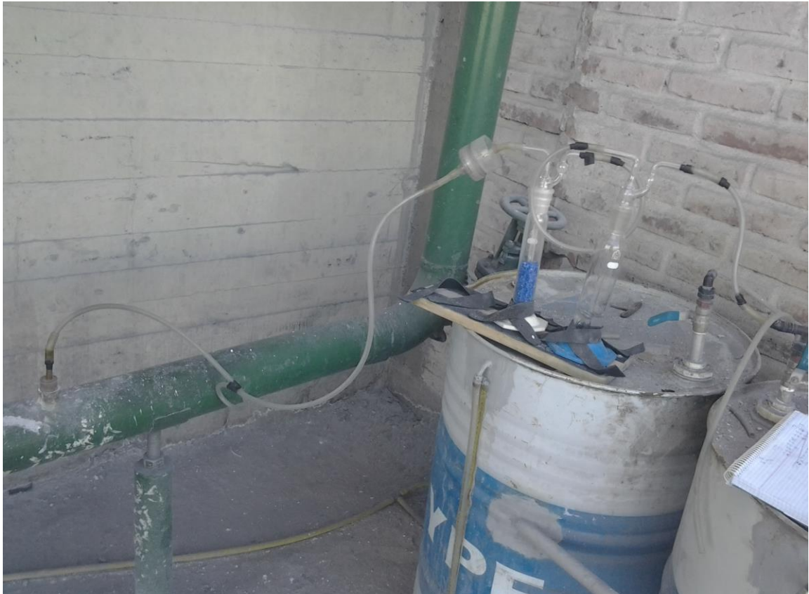
Fig. 30; Tachos de agua para generación de succión por vacío. Se observa circuito de muestreo.
