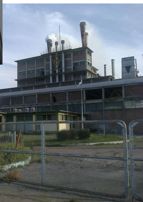
Fig. 10: Vista desde el exterior del frente de la planta de El Nihuil.
