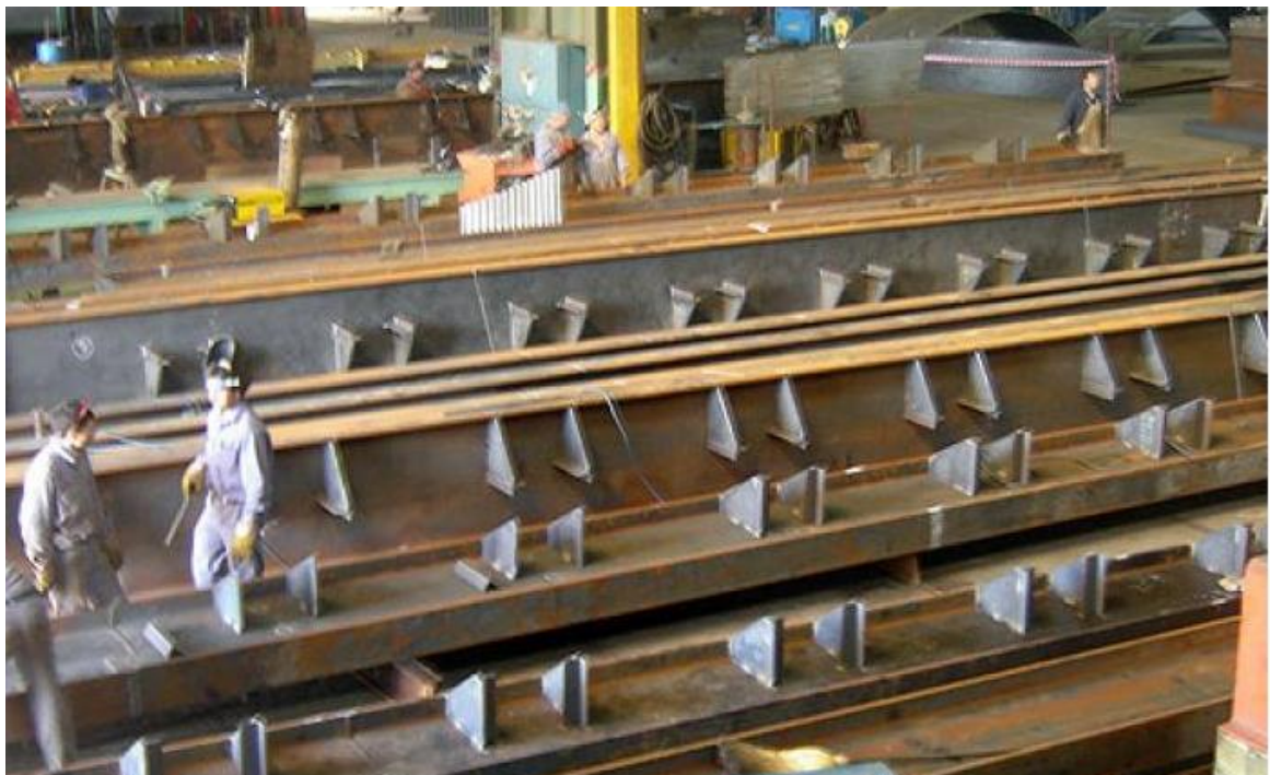
Fig 6: Montaje y fabricación del techo horno de fundición para SIDERAR.
