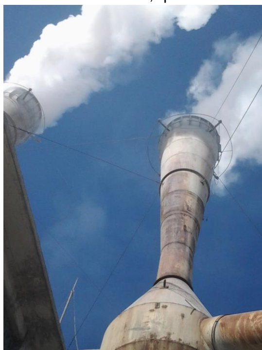
Fig. 65: Chimeneas expulsando microsilice y vapor de agua
