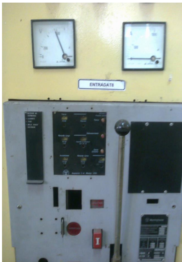
Fig 23: Seccionador entrada trafo T8.
