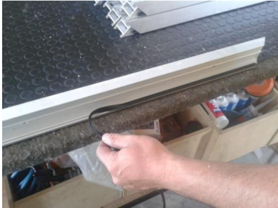
Colocación de burletes y felpas
