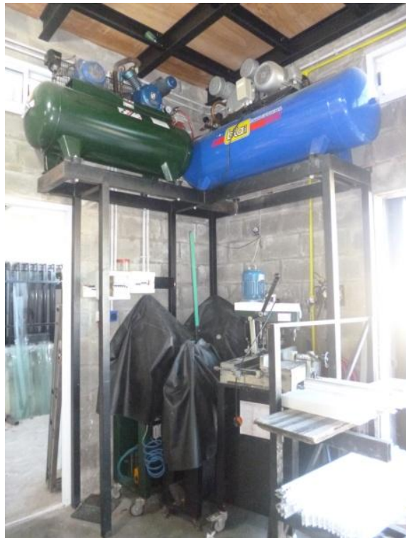
Instalación de equipos de aire comprimido
