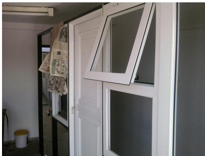
Puertas ciegas, ventanas proyectantes
