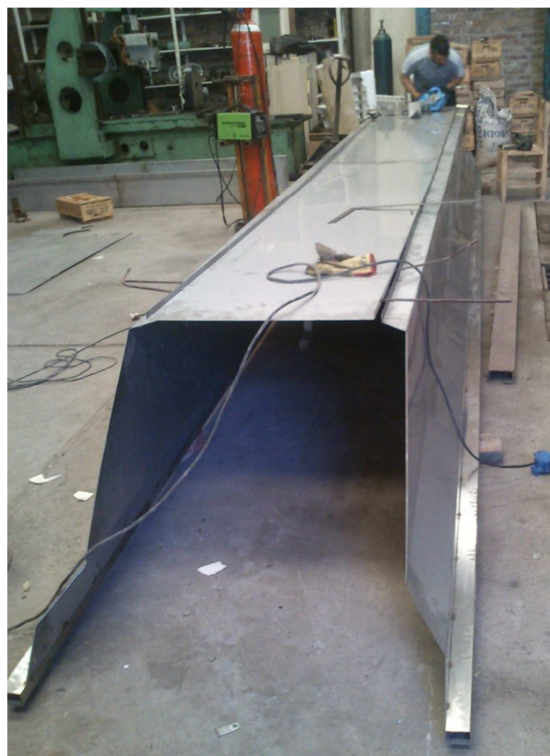
Colocación del fondo y de los caños estructurales para rigidizar los laterales del lagar
