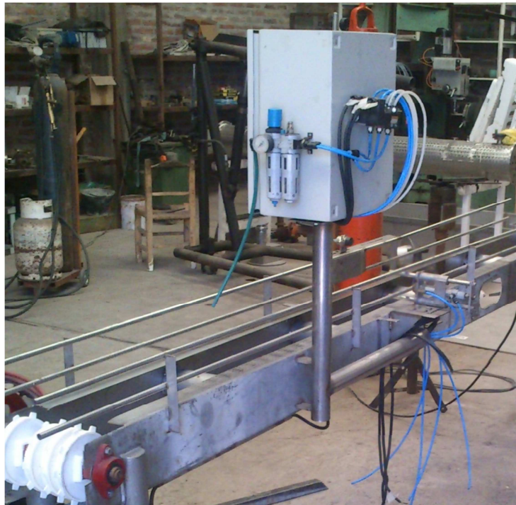
Reubicación de electroválvulas y unidad FRL
