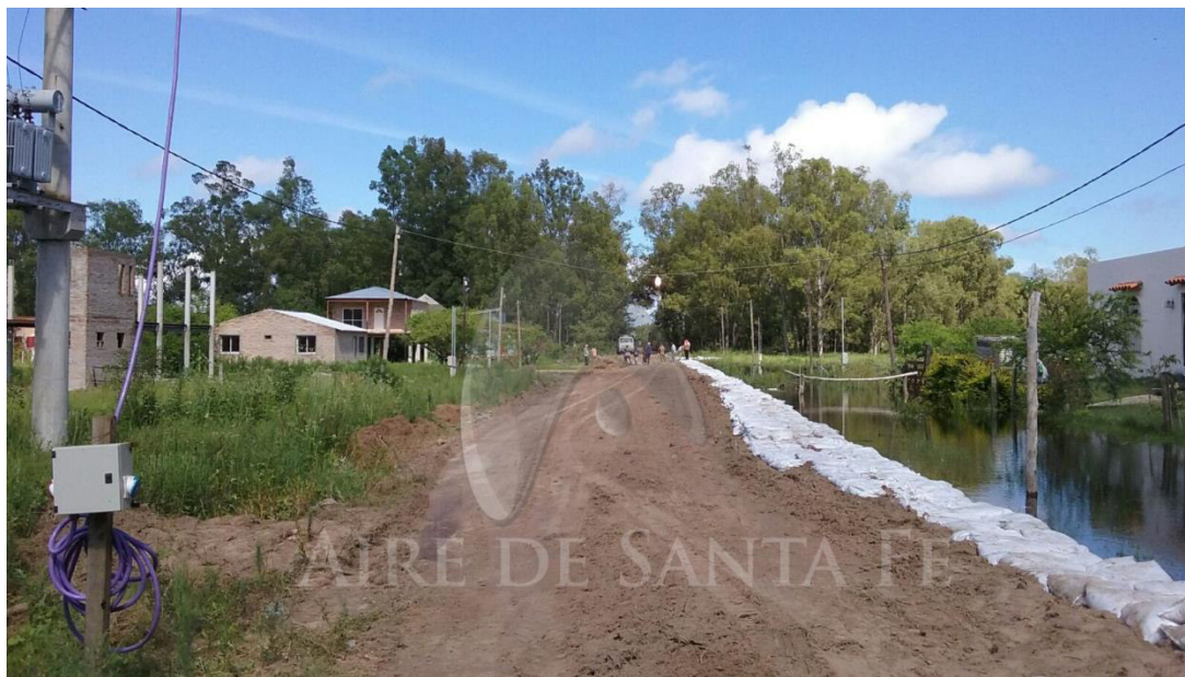
Figura 2.10 | Calle Zapata Gollán, 400 metros al Oeste de la RPN°1 -entre Argentina Molinari y Rodolfo Farías Paez, zona inundable-. Época de creciente con defensa parcial temporal (30/12/2015). Fuente: http://www.airedesantafe.com.ar/ -
