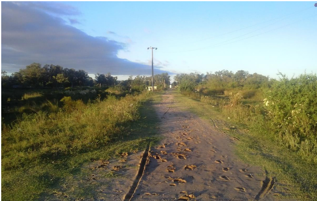
Figura 2.13 | Defensa Este reconstruida. Sobre sus taludes se ha desarrollado una buena cubierta vegetal, fundamental para su protección contra el oleaje y los factores climáticos.-
