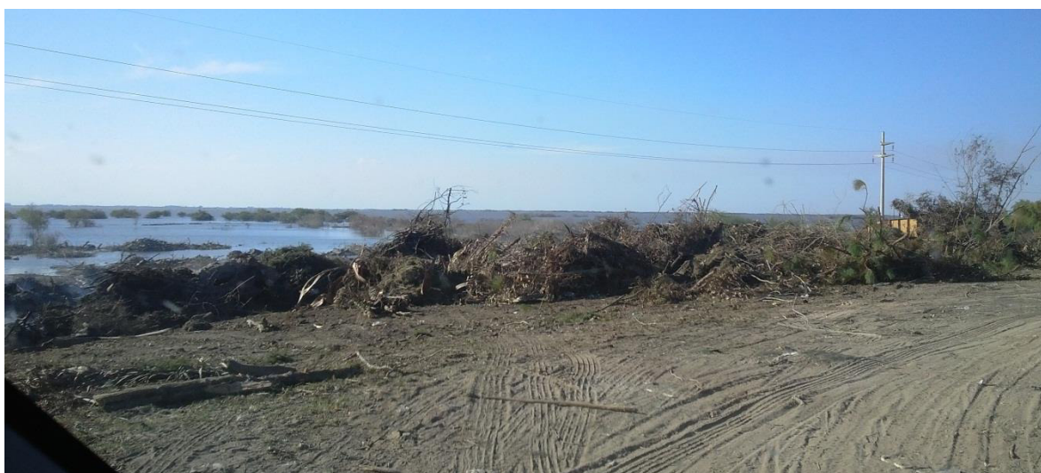
Figura 2.45 | Gran cantidad de residuos vegetales sobre el talud Oeste de la defensa.-
