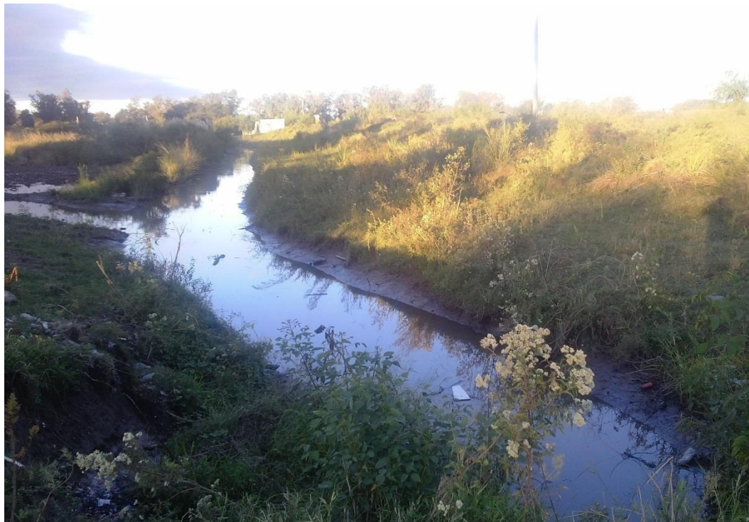
Figura 2.14 | Canal de recolección de las aguas de infiltración de la defensa de tierra, recientemente acondicionado y desmalezado.-
