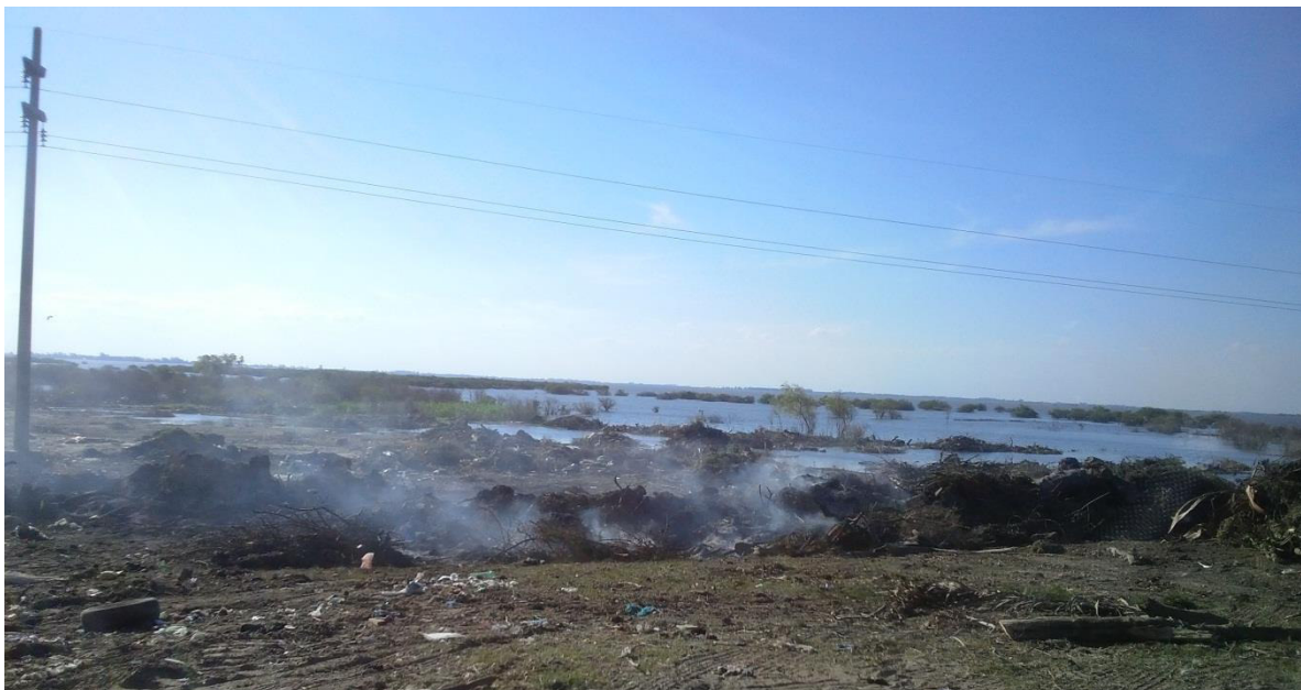
Figura 2.49 | Quema de residuos sobre el talud Oeste. En la fotografía se puede observar la presencia del tendido eléctrico, que podría ser afectado por las llamas.-
