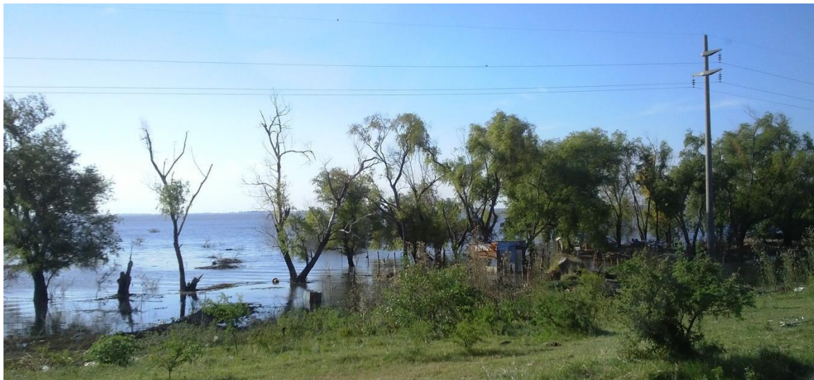
Figura 2.21 | Vivienda y corral para animales construidos sobre el talud mojado del Terraplén Juan Domingo Perón.-
