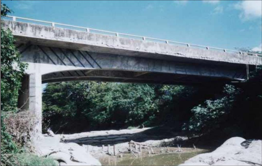
*Figura 6.53: Vista lateral del puente con el refuerzo terminado [11].*
