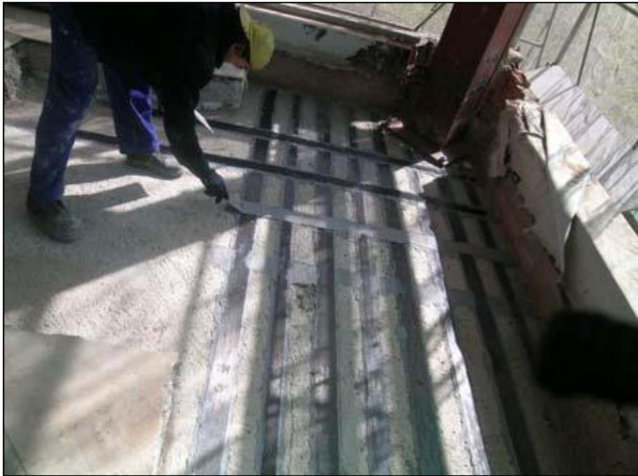
*Figura 6.47: Trabajos para reforzar una losa [12].*
