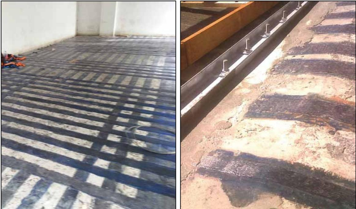
*Figura 7.12: Vista del trabajo terminado (izquierda) y detalle sobre el borde de un apoyo (der.) [42].*
