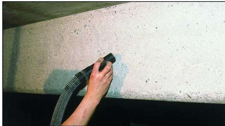
*Figura 6.14: Preparación de la superficie de hormigón [12].*
