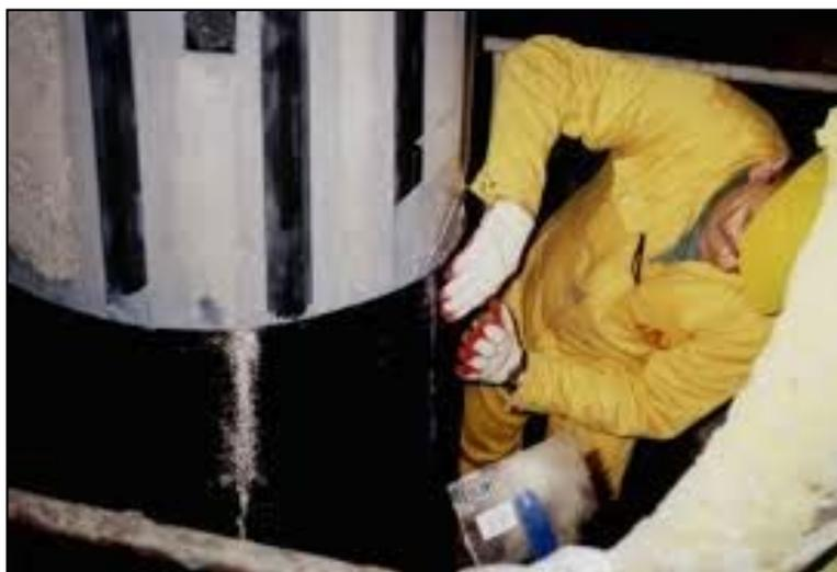
*Figura 6.48: Confinamiento realizado en combinación de los dos métodos (vía húmeda y vía seca) [11].*
