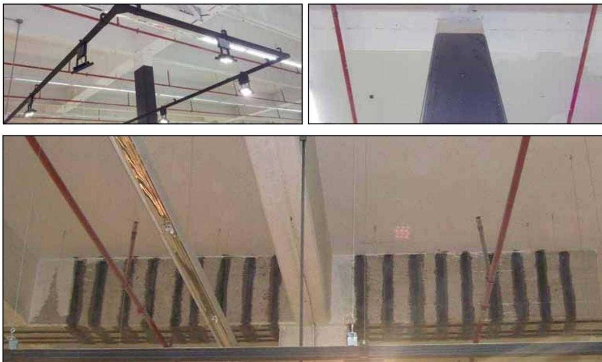
*Figura 7.8: Vista de los refuerzos estructurales realizados [40].*
