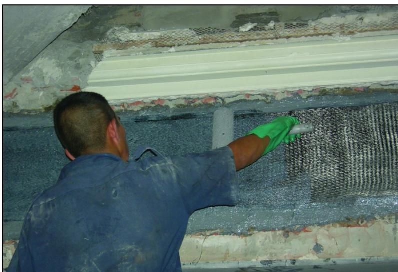
*Figura 7.5: Aplicación del adhesivo Sikadur® 330 [39].*
