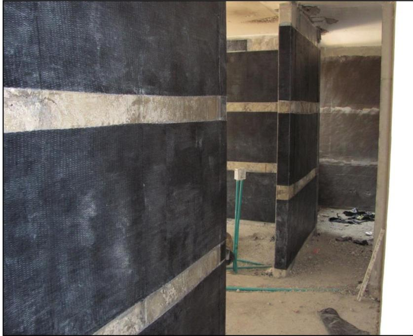
*Figura 6.50: Refuerzo de muros [11].*
