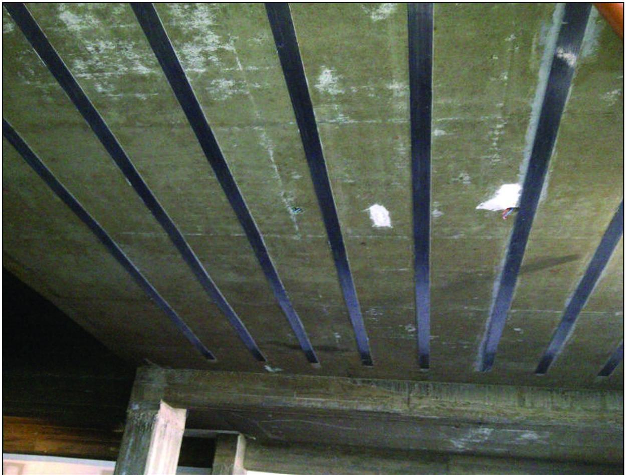
*Figura 7.2: Refuerzo de losa con laminas de PRFC [38].*
