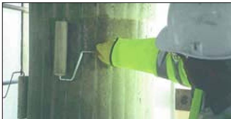
*Figura 6.20: Aplicación de adhesivo epoxi [12].*
