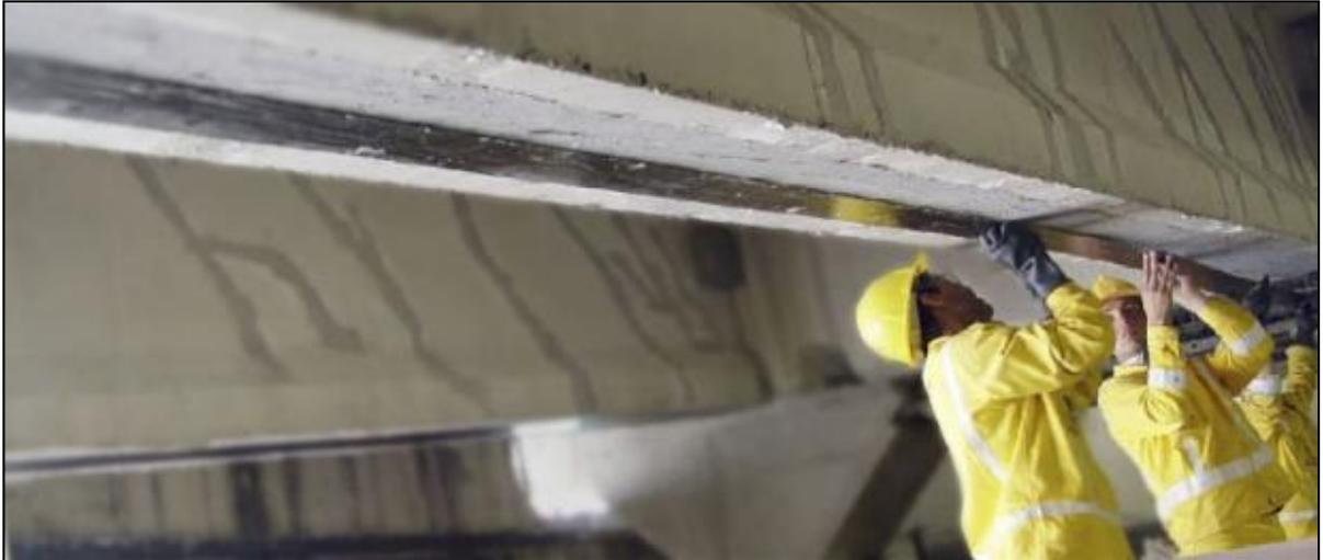
*Figura 6.46: Trabajos para reforzar una viga [12].*
