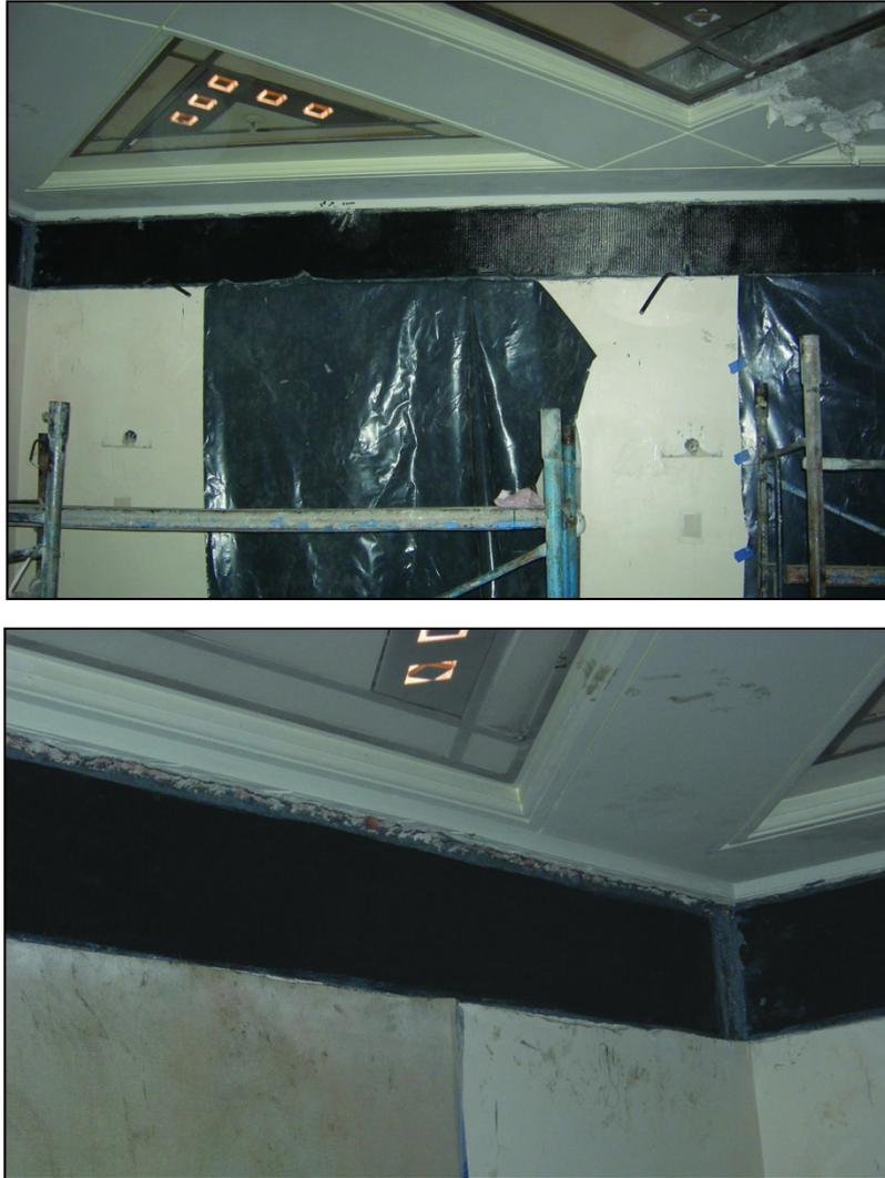
*Figura 7.6: Vista de las vigas reforzadas [39].*
