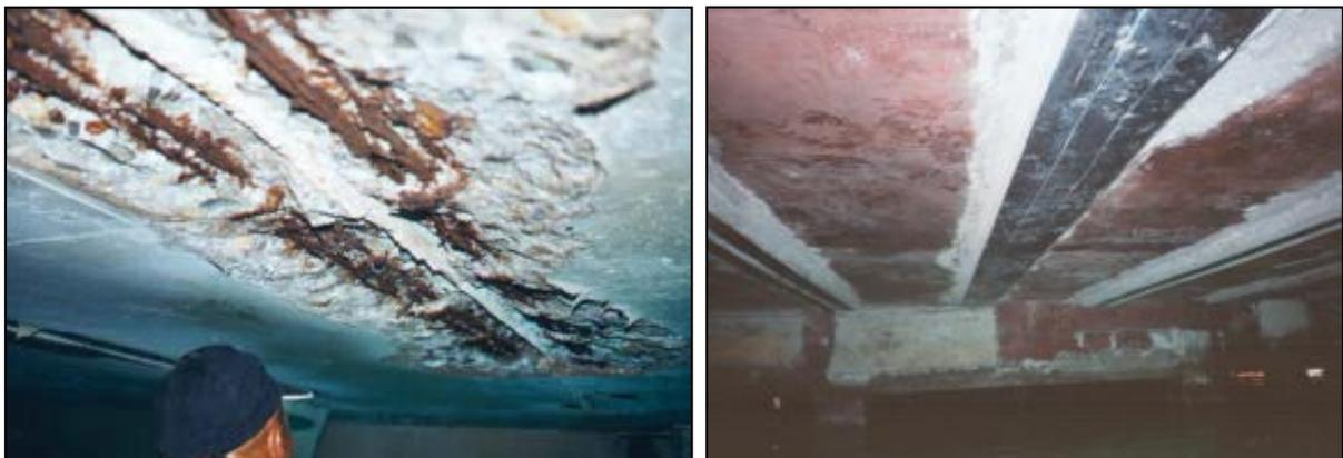
Figura 6.38: Refuerzo en secciones debilitadas [11].
