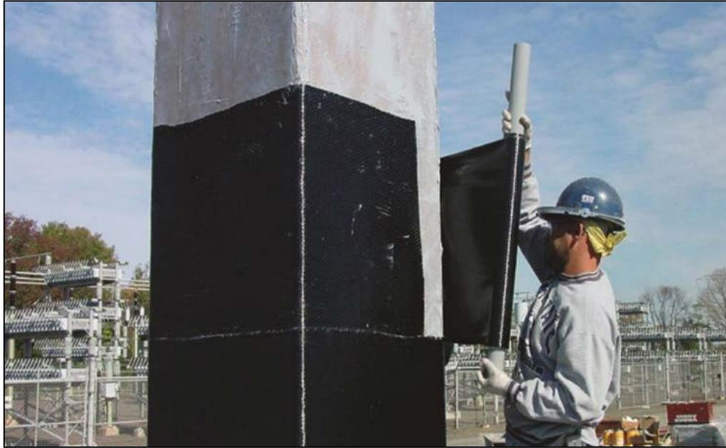
*Figura 2.14: Refuerzo de una columna con el sistema SikaWrap® Hex [9].*
