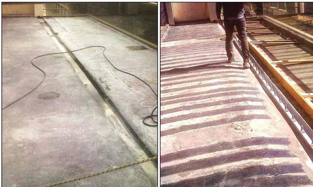
*Figura 7.11: Vista de losa a reforzar (izquierda) y refuerzo aplicado (derecha) [42].*
