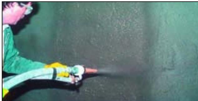
*Figura 6.18: Aplicación de un recubrimiento sobre el refuerzo terminado [12].*
