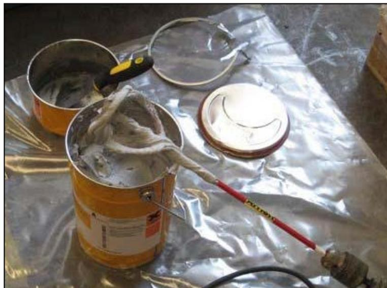
*Figura 6.26: Mezclado de la resina [12].*
