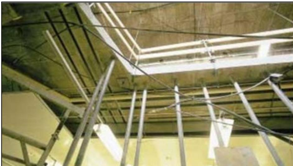
*Figura 6.36: Apertura de losas para ascensores y escaleras mecánicas [11].*
