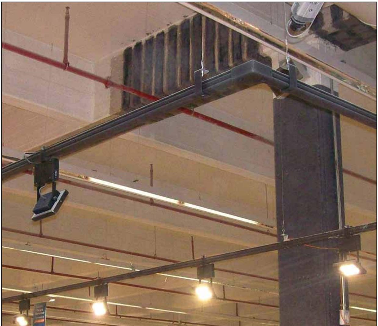
*Figura 7.7: Vista de los refuerzos estructurales realizados [40].*
