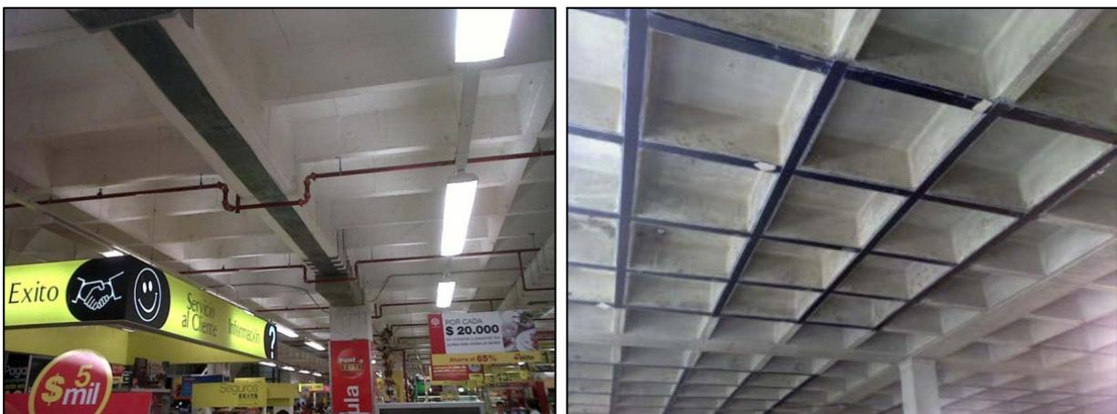
*Figura 6.31: Refuerzo de vigas de gran luz y losas casetonadas para aumentar su capacidad de carga [11].*
