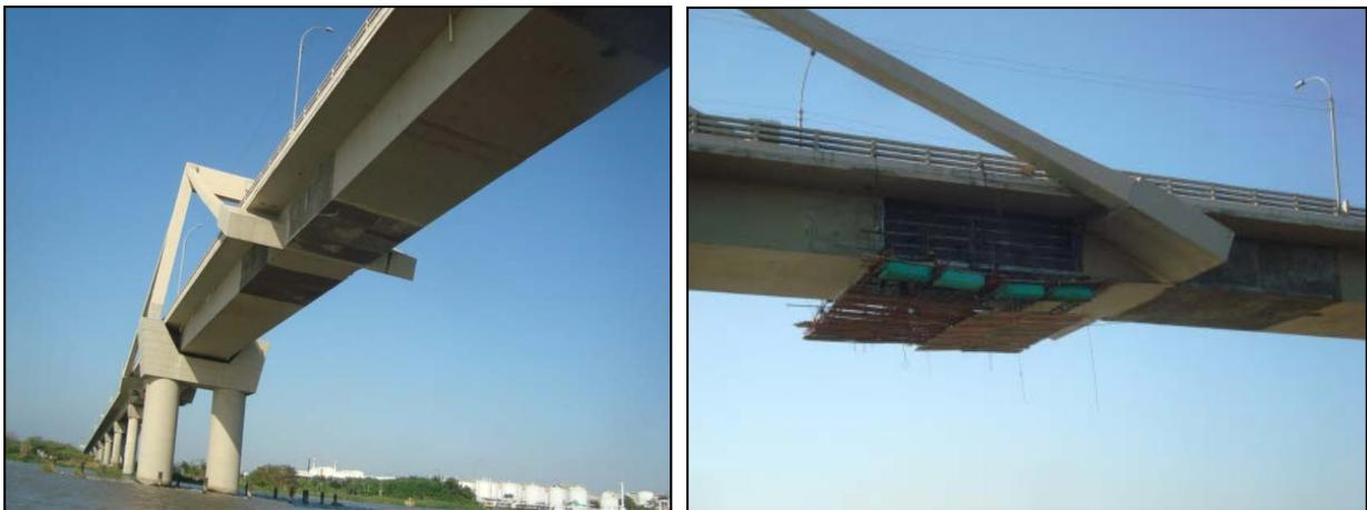
*Figura 6.41: Refuerzo para impedir el avance de fisuras en el Puente Pumarejo, Colombia [36].*
