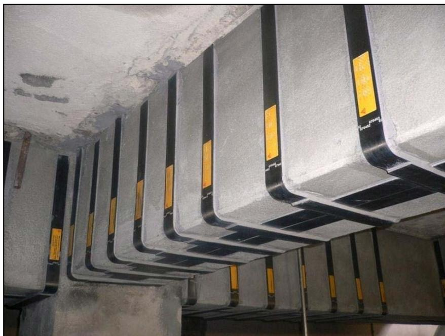
*Figura 2.11: Láminas Sika® CarboDur® aplicada en forma de L [8].*
