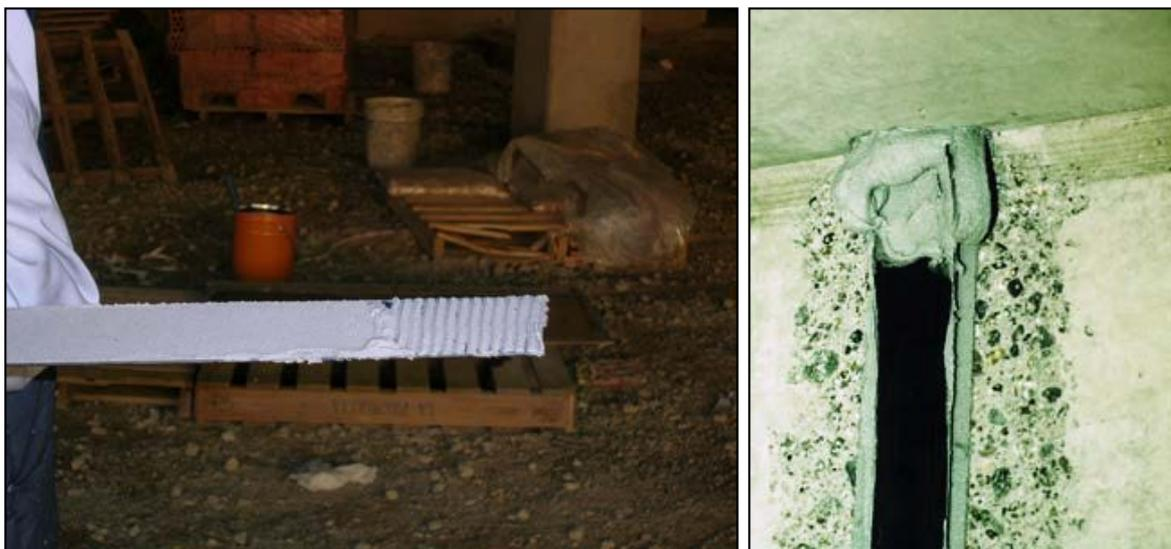
*Figura 6.12: Anclaje de la lámina en la abertura [21].*
