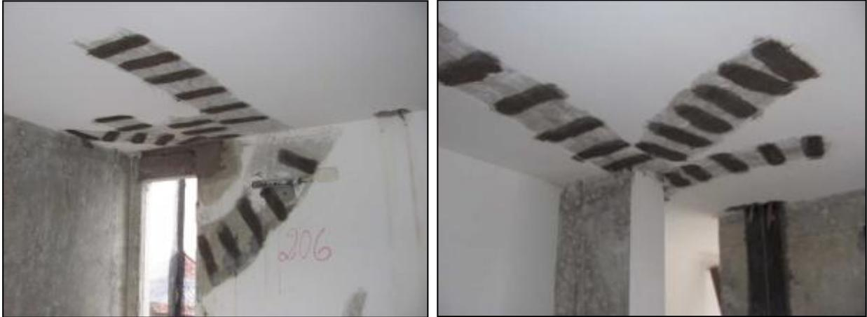
*Figura 6.42: Refuerzo para impedir el avance de fisuras en tabiques y losas [11].*
