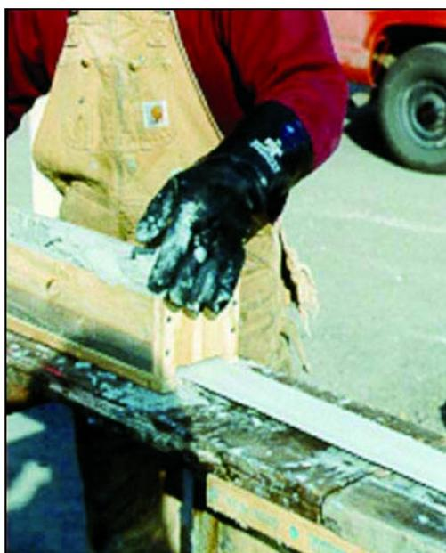
*Figura 6.7: Aplicación de la resina sobre el laminado [12].*
