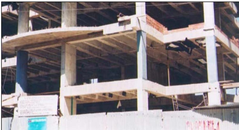
*Figura 6.29: Estructura con columnas del primer piso hormigonadas con hormigón de baja resistencia [11].*
