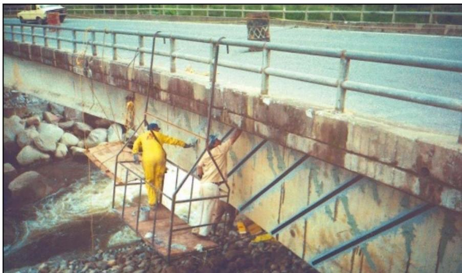
*Figura 6.33: Primera aplicación de un sistema de PRFC en Latinoamérica. Puente Cocorná, Colombia [11].*
