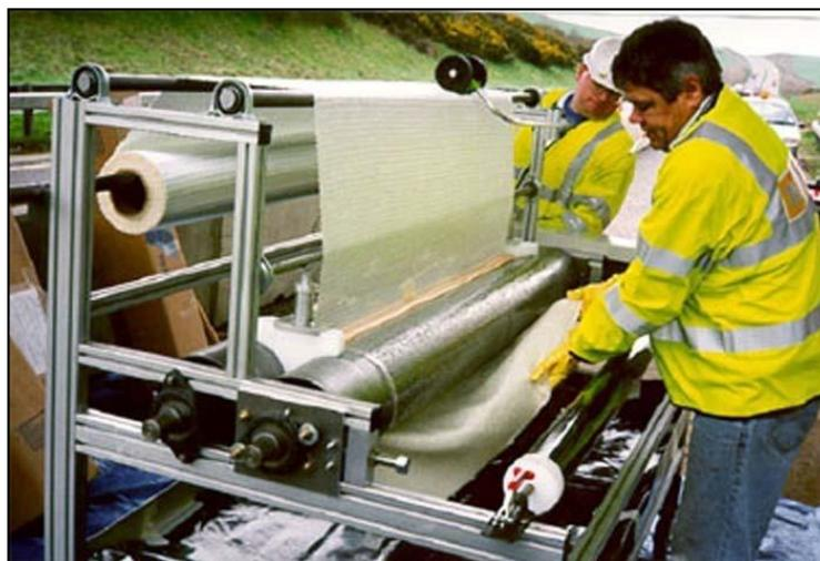
*Figura 6.23: Impregnación mecánica con adhesivo epoxi [12].*
