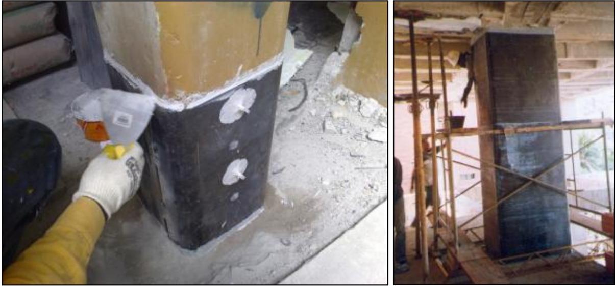
*Figura 6.30: Refuerzo con encamisado metálico vs. sistema SikaWrap de PRFC [11].*
