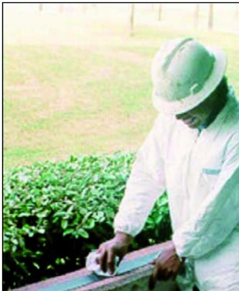
*Figura 6.6: Limpieza del laminado con un limpiador y un trapo hasta que quede libre de polvo u otros contaminantes [12].*
