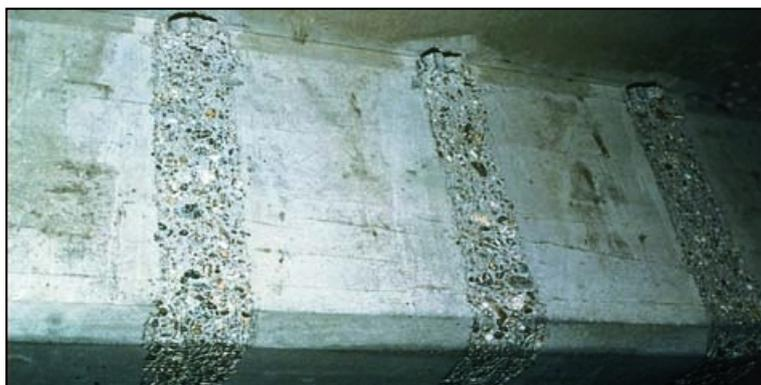
*Figura 6.3: Escarificado del hormigón previo a la aplicación del adhesivo [12].*
