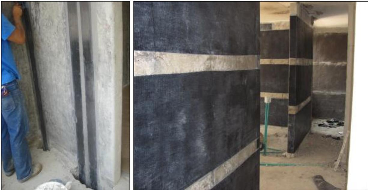
*Figura 6.40: Refuerzo de los muros con el sistema SikaWrap y Carbodur [11].*
