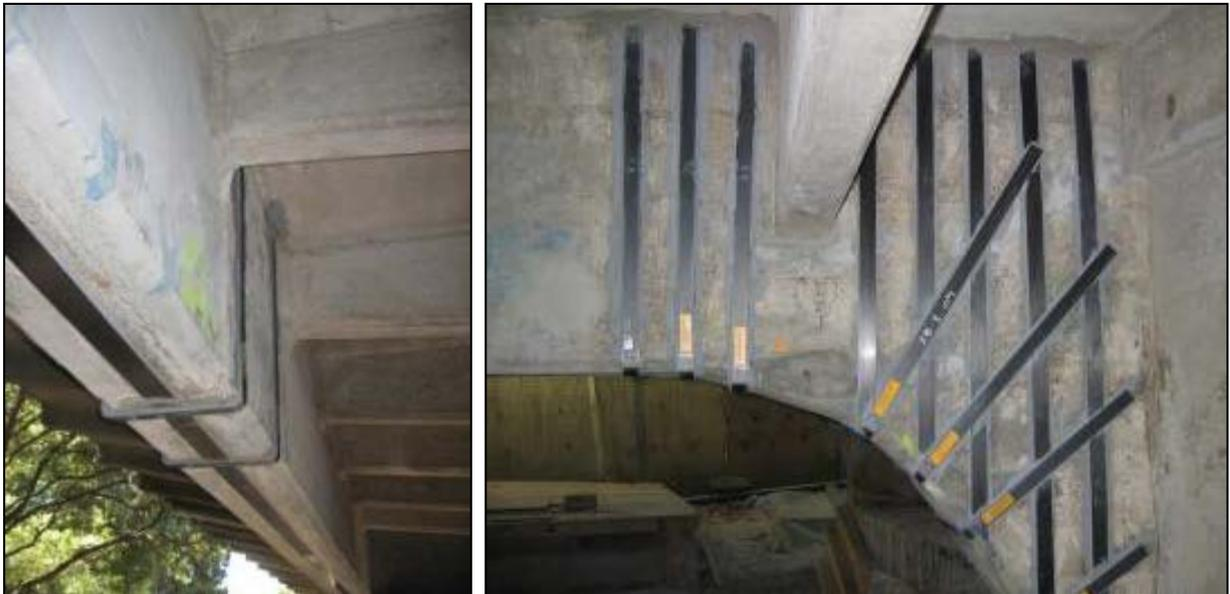
*Figura 6.32: Refuerzo de puente para aumentar su capacidad de carga [35].*
