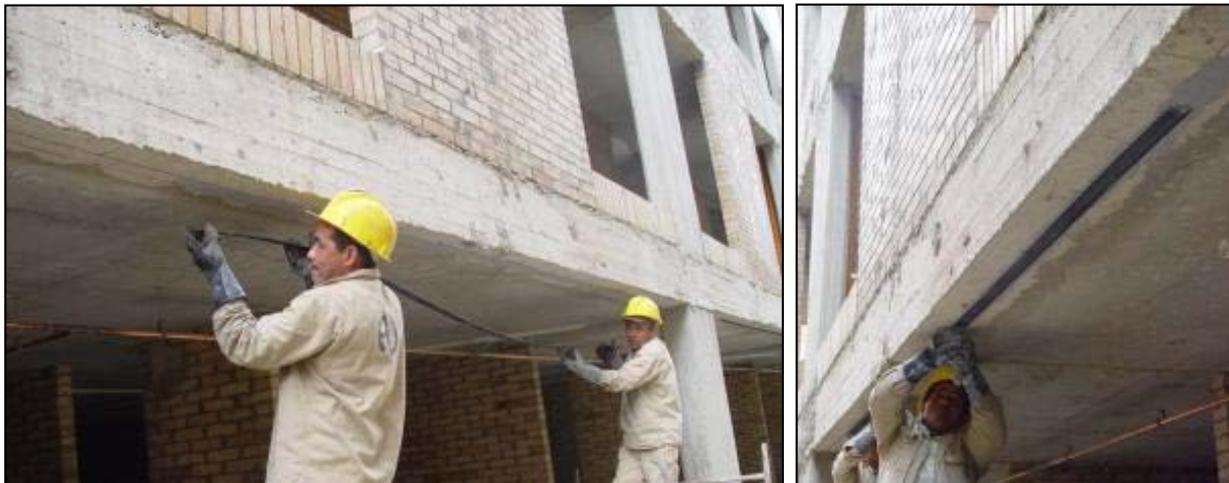
*Figura 6.27: Refuerzo con láminas de PRFC en seco en vigas de dimensiones insuficientes [11].*
