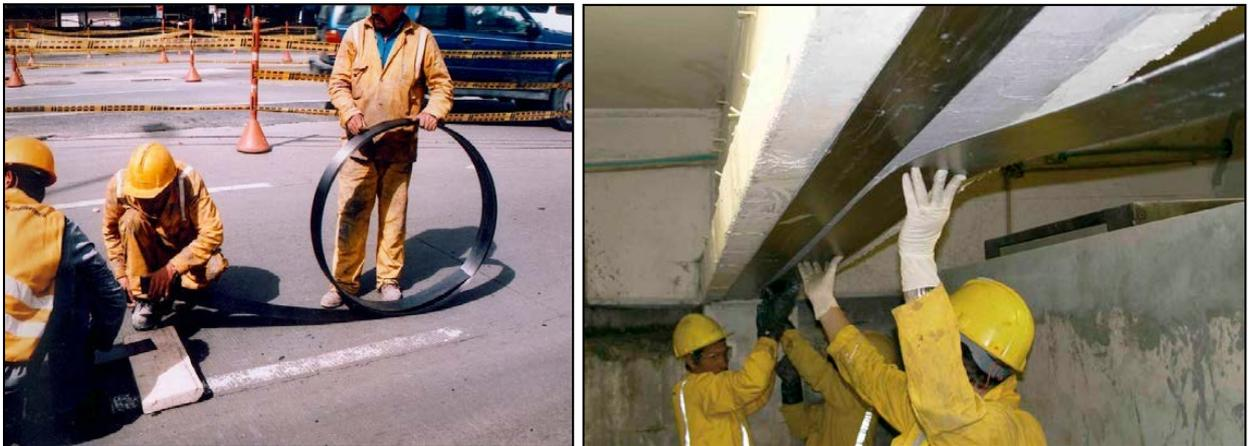
*Figura 2.10: Aplicación de láminas Sika® CarboDur® [8].*
