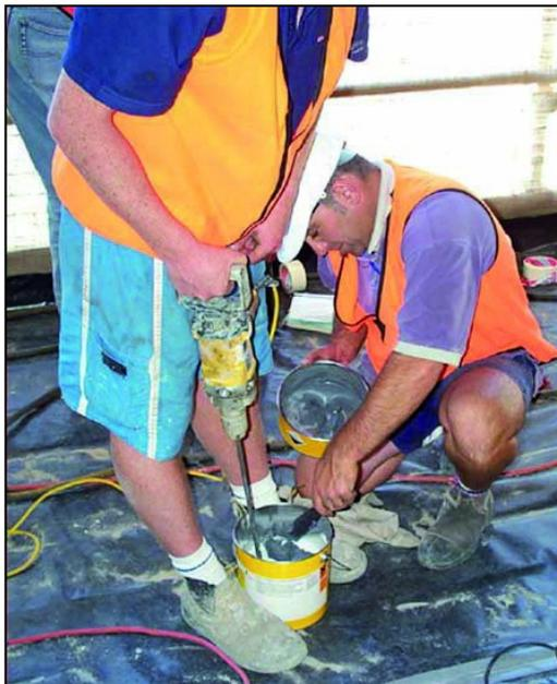
*Figura 6.5: Mezcla del adhesivo epoxi. [12].*
