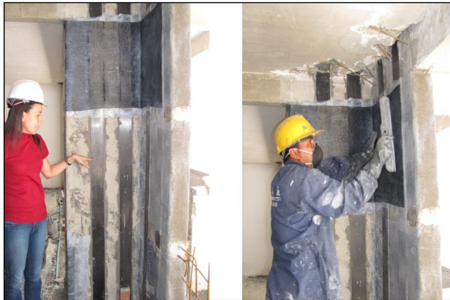
*Figura 6.51: Refuerzo de muros [11].*
