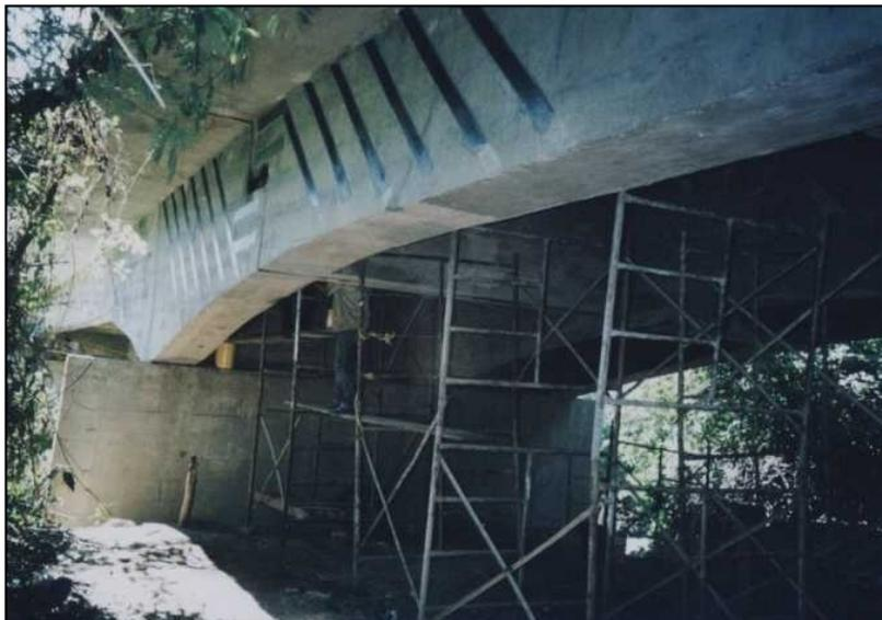
*Figura 6.54: Vista lateral – inferior del puente con el refuerzo terminado [11].*
