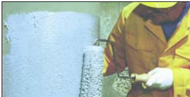
*Figura 6.16: Aplicación de adhesivo epoxi [12].*
