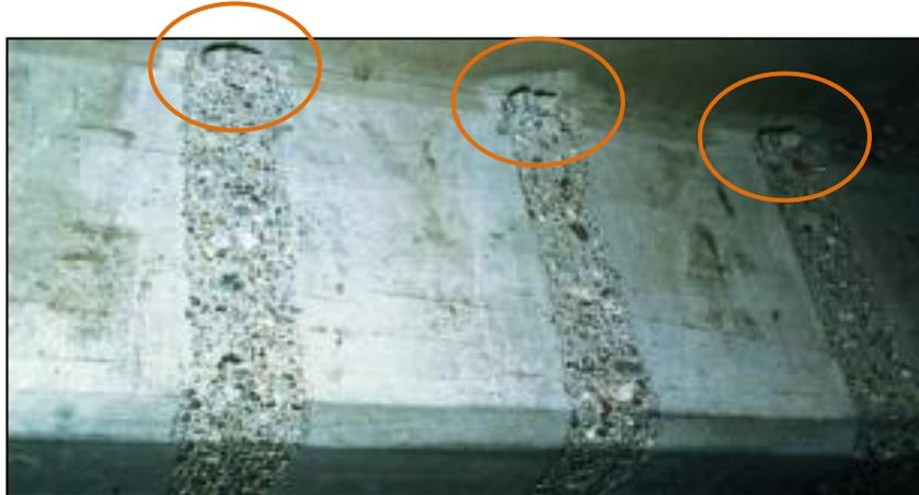
*Figura 6.11: Preparación de la superficie de hormigón [12].*
