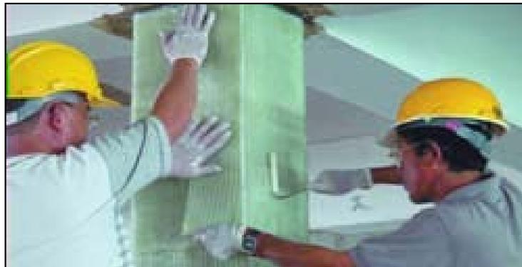
*Figura 6.24: Aplicación del tejido pre-humectado (arriba y abajo)[12].*
