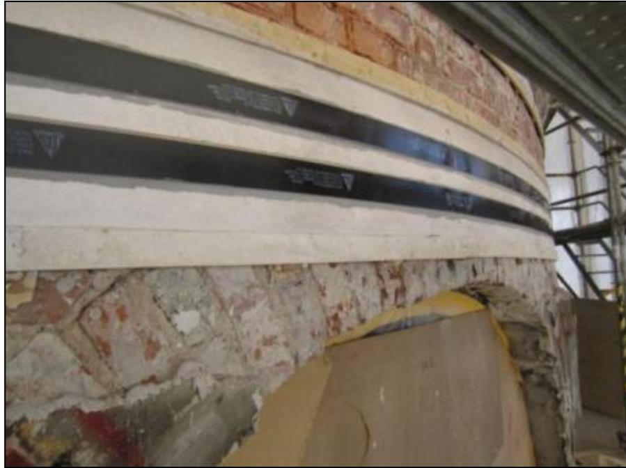
*Figura 6.35: Refuerzo en estructuras debilitadas [11].*
