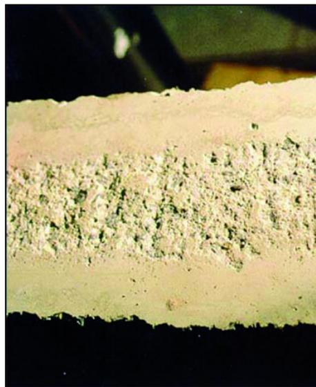
*Figura 6.4: Preparación del soporte [12].*
