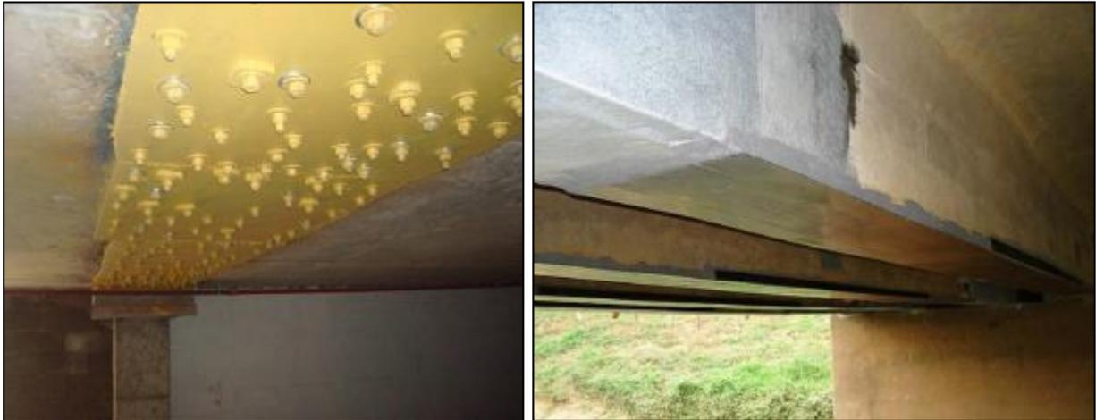
*Figura 6.28: Refuerzo con láminas metálicas vs. láminas de PRFC en vigas de cuantía insuficientes [11].*
