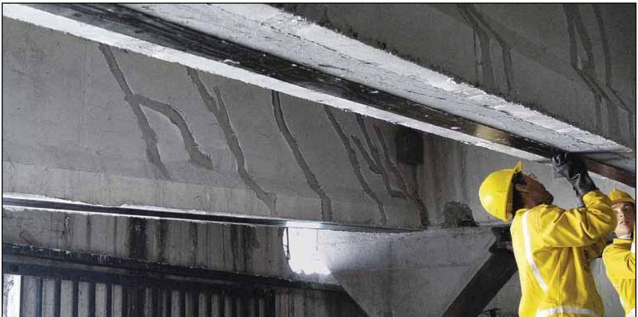
*Figura 6.8: Colocación del laminado sobre el soporte y pasado de rodillo [12].*
