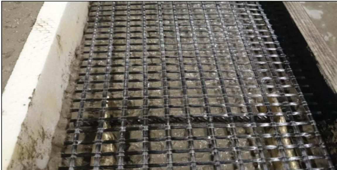
Figura 4.31: Hormigonado y colocación de las mallas.
