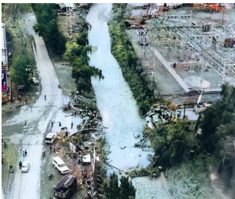
Ilustración 31: Colapso de Canal Cacique Guaymallén, imagen de Diario Mendoza
