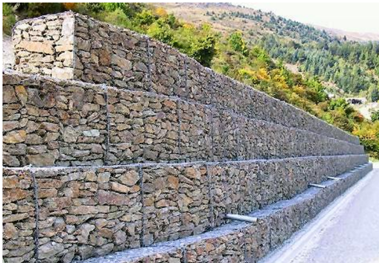
Ilustración 69: Ejemplificación de gaviones caja
