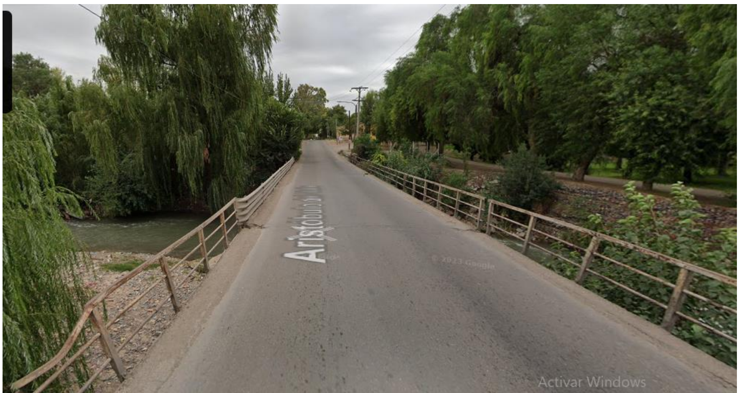
Ilustración 4: Cruce vial sobre canal Cacique Guaymallén, calle Aristóbulo del valle
