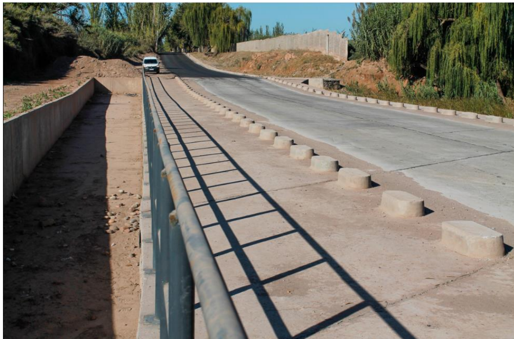
Ilustración 16: Puente badén en calle Nuestra Señora del Carmen, Gllén, Mza
