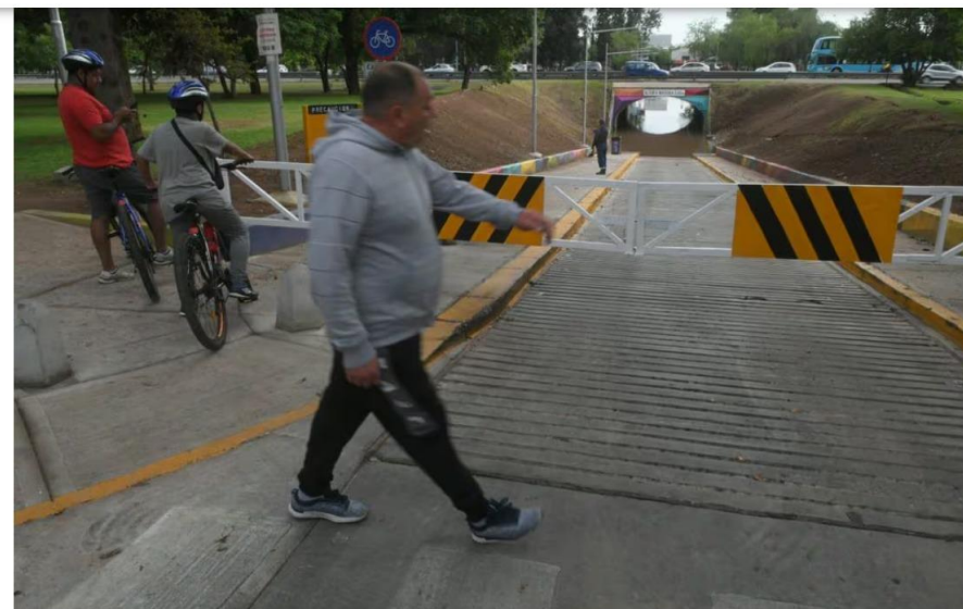
Ilustración 13: Barrera para cierre de puente badén
