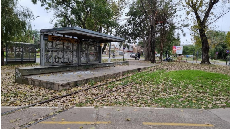
Figura 49: Estado actual de las ex estaciones de Tren Urbano.
