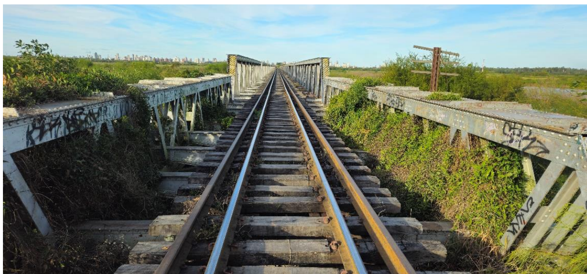
Figura 133: Situación actual del Puente ferroviario Santo Tomé-Santa Fe.
