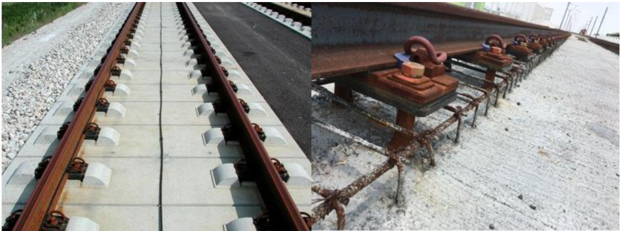
Figura 63: vía sobre losa de hormigón armado
