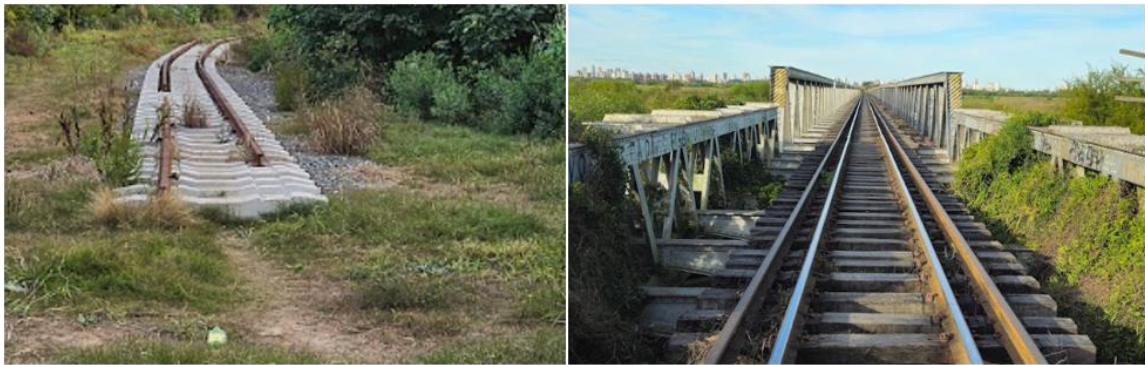
Figura 82: Fin vía nueva (izquierda) e inicio puente ferroviario (derecha).
