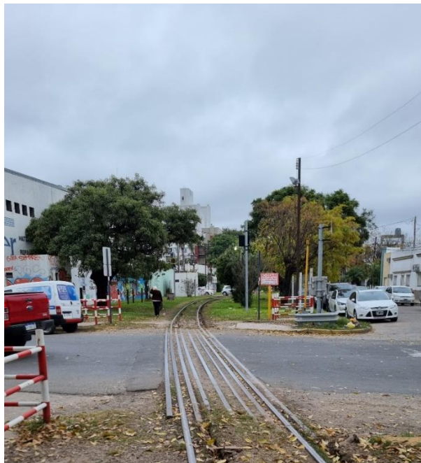
Figura 33: Paso a nivel en intersección con Av. Aristobulo de Valle.
