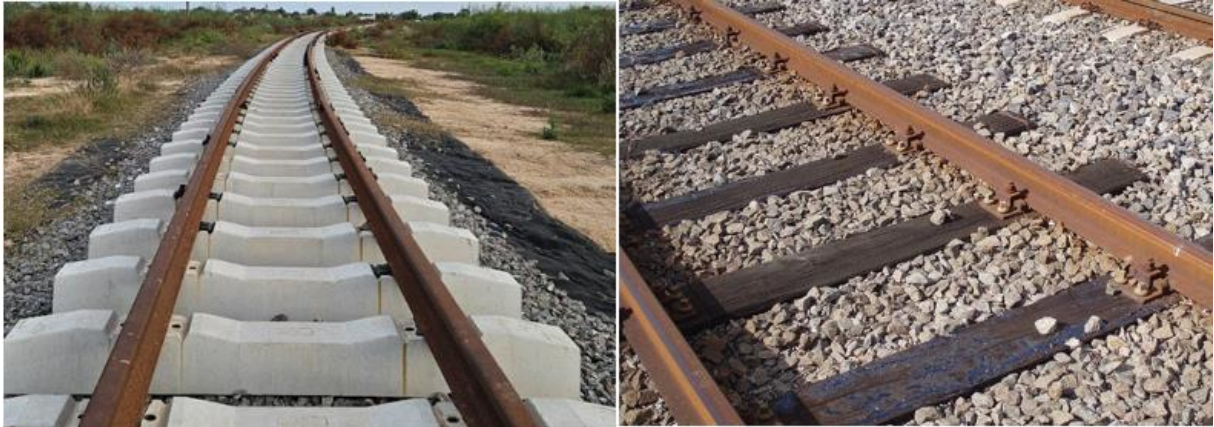
Figura 68: Durmientes de madera (izquierda) y de hormigón (derecha).
