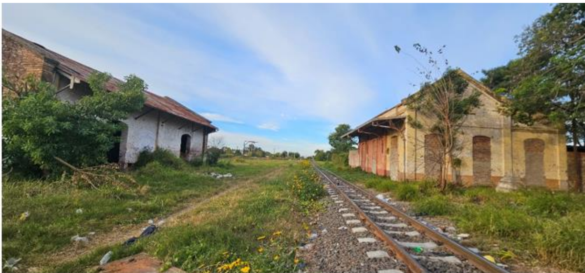
Figura 130: Predio de implantación de la Estación de Transferencia 1.
