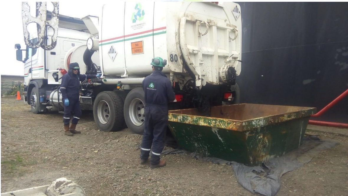
Foto 6. Dos trabajadores depositando sedimentos desde el equipo vector.
