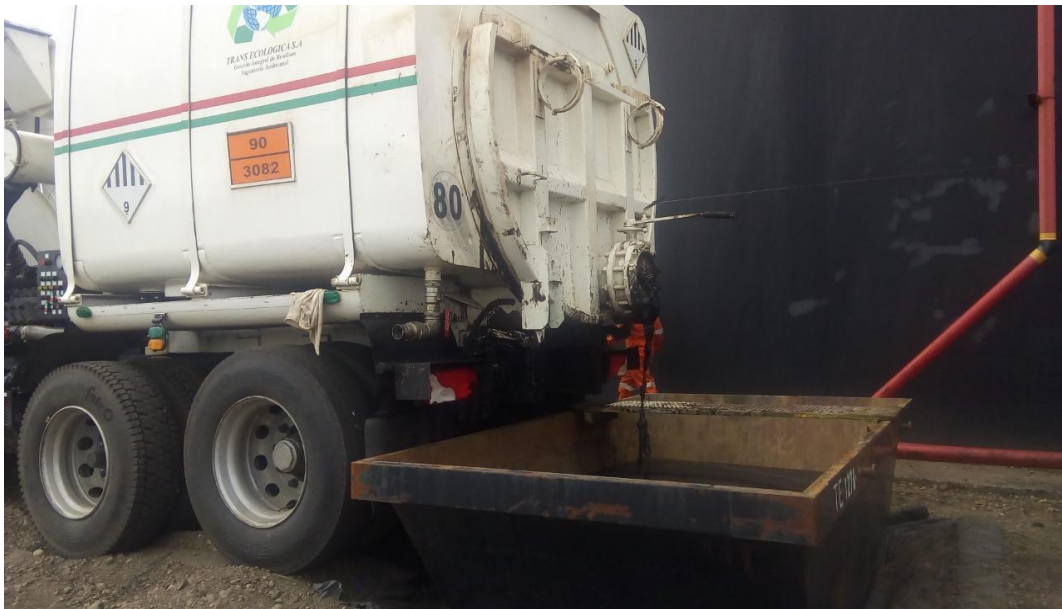
Foto 9. Equipo vector dispone los sedimentos retirados dentro del volquete.
