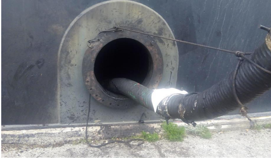
Foto 7. El equipo vector succiona sedimentos del interior del tanque a través de la boca de hombre, operado por los trabajadores.
