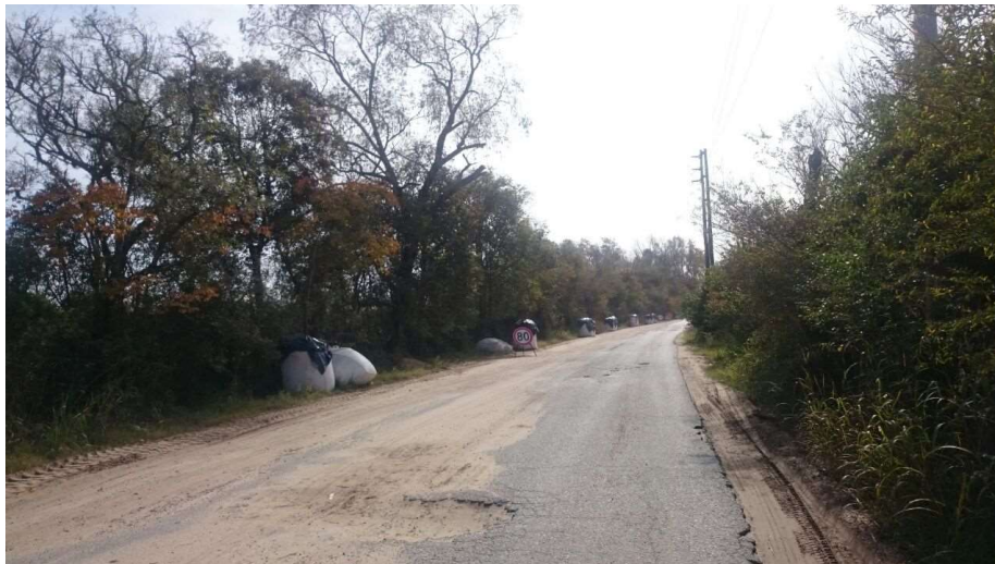
Imagen 3.6 - Estado Actual Ruta Provincial N°25.
