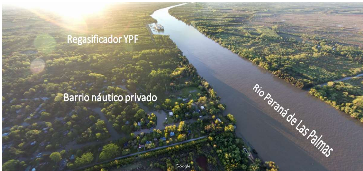
Imagen 3.2 - Vista periférica de la Zona Ribereña del Partido de Escobar- Sentido Norte.
