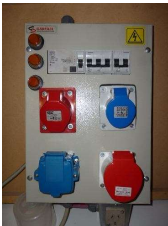
Imagen 5.3.A - Sistemas de TUG. De izquierda a derecha: Tipología de tablero seccional con tomacorrientes, Toma corrientes exterior.
