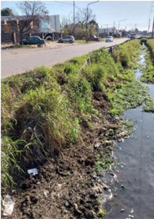
*Figura N°25 Desmoronamiento de talud y guardarrail*
