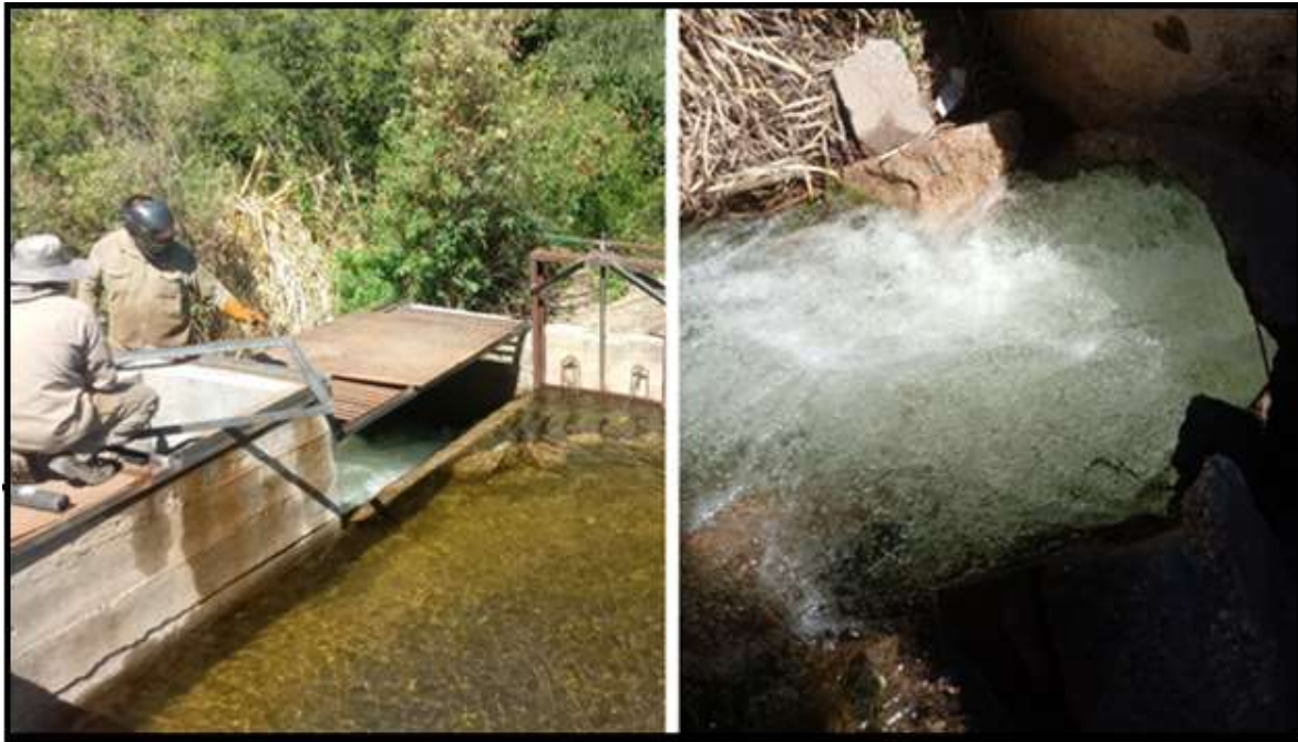
Figura 48: Descarga del excedente de agua en obra de toma de captación de agua en Azud Paso de los Sauces ( Punto 1 ). Imagen tomada en marzo del año 2019 al momento de construir pasarelas de acceso a compuertas del sistema de filtrado de agua.
