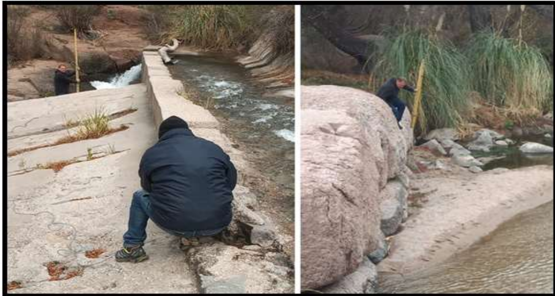
Figura N° 54: Corroboración de niveles con manguera de nivel y reglas verticales. Imagen tomada en el mes de junio del año 2023 al momento de realizar relevamientos de alturas de saltos para posibles emplazamientos de Casas de Máquinas.
