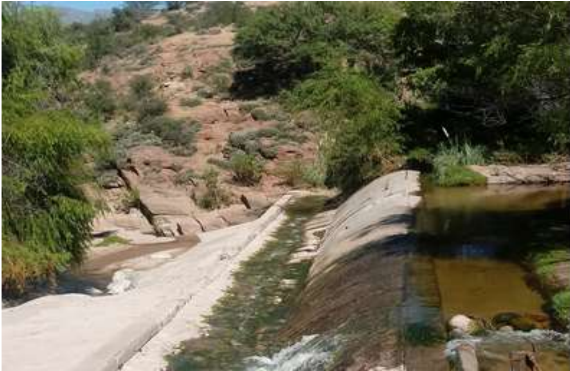
Figura 17: Vista del vertedero de cimacio. Situado sobre el lateral derecho del Río Huaco en el Azud Paso de los Sauces. Imagen tomada en el mes de marzo del año 2019. (Aegerter, 2023 Microcentrales hidroeléctricas; una alternativa limpia y amigable con el ambiente, posibilidad de aplicación en la Provincia de La Rioja).
