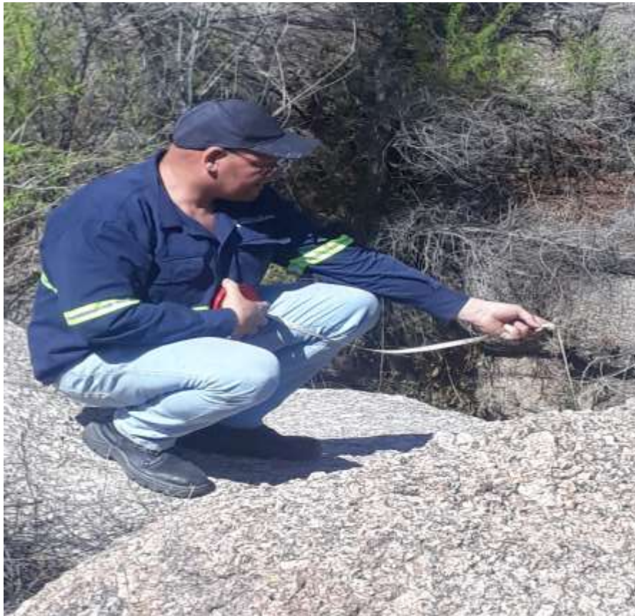
Figura 55: Corroboración de niveles con cinta métrica y contrapeso en acantilado vertical. Imagen tomada en el mes de agosto del año 2023 al momento de realizar relevamientos de alturas de saltos para posibles emplazamientos de Casas de Máquinas.
