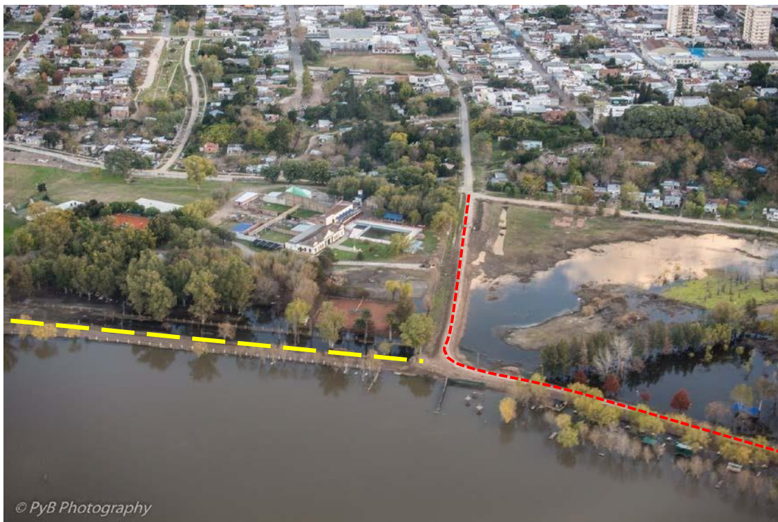
Figura 34. Fin de terraplén en la esquina del Tiro Federal (mayo de 2016) 4
