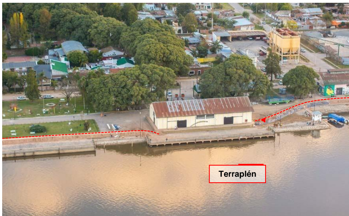
Figura 31. Puerto de Baradero con terraplén de defensa temporario (mayo de 2016) 1
