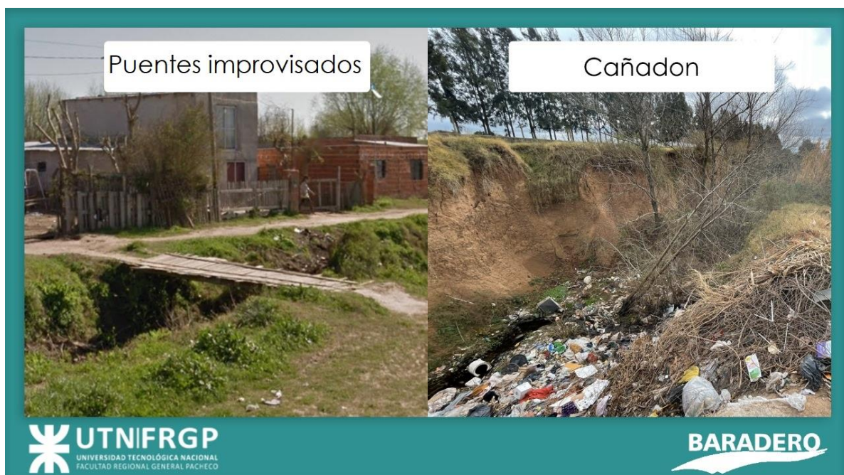
Ilustración 21 - Fotos Zanja Antartida Argentina. Fuente: propia
