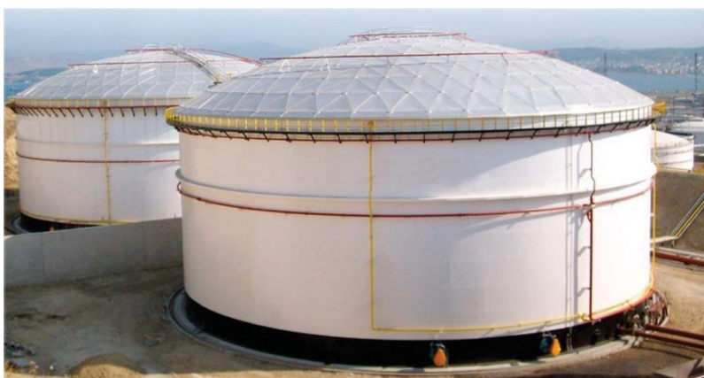
Ilustración 71: Tanque con techo flotante.
