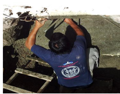
Figura 4 b) – Colocación de sensores
