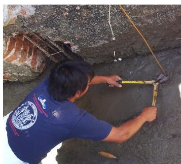
Figura 4 a) – Colocación de sensores
