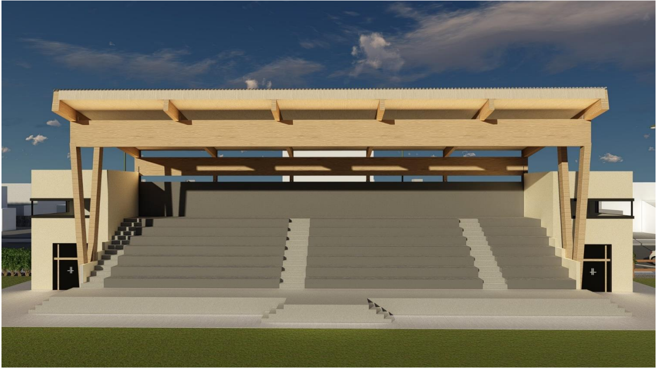
Imagen 83: Estructura de madera y cubierta en tribuna existente Fuente: Elaboración propia
