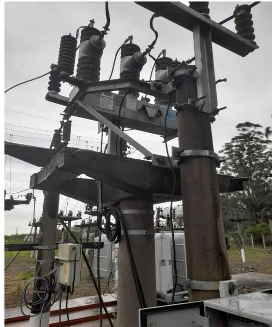
Ilustración 22 Estructura con montaje del equipo restaurador
