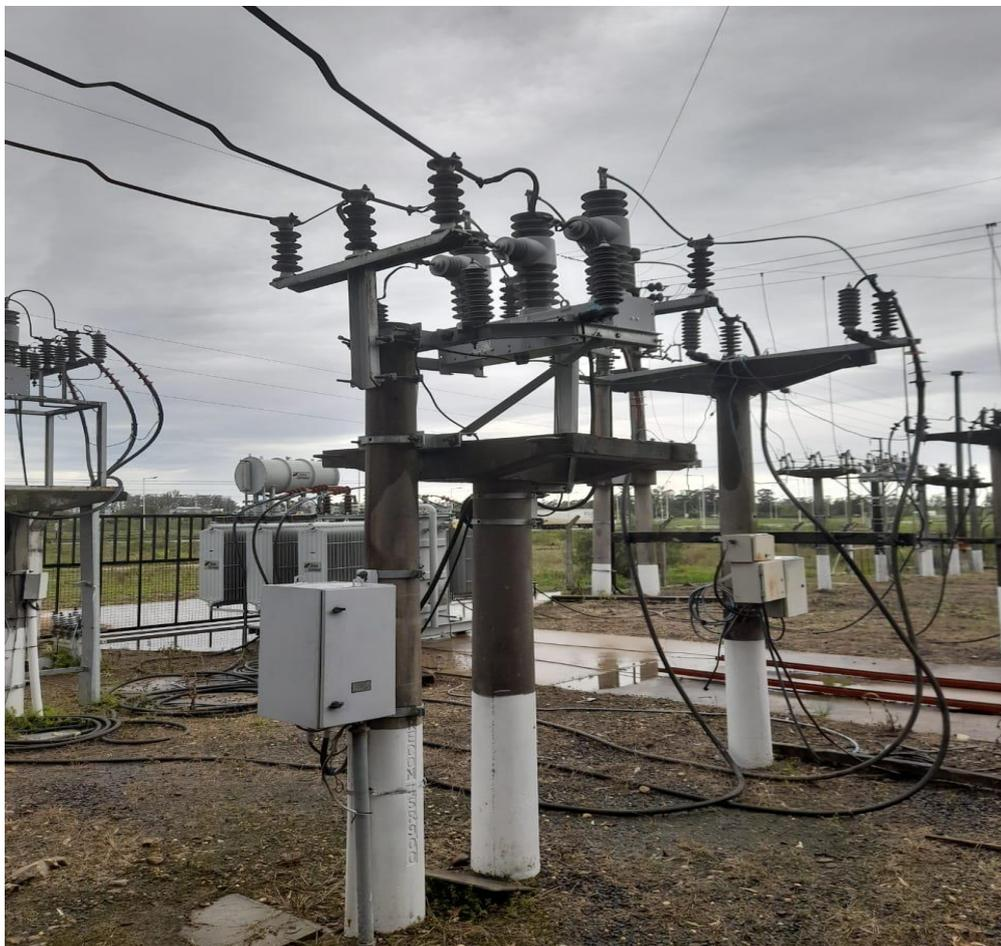
*Ilustración 1 Reconectores Cooper Nova instalados*
