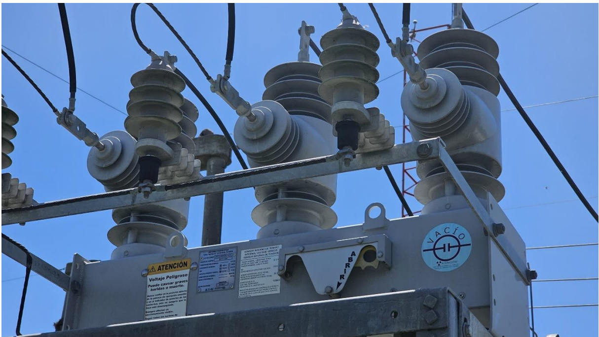
Ilustración 7 - Reconector Cooper Form 6
