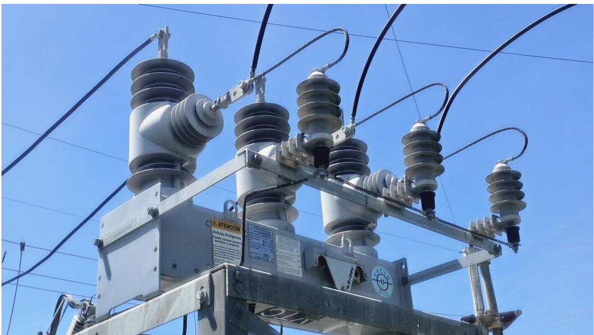
Ilustración 8 - Reconector Cooper Form 6 2
