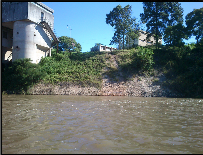
Foto 21-cobertura vegetal sobre el muro marginal, como consecuencia de la falta de sellado de juntas. (orientación de fotografía Suroeste)
