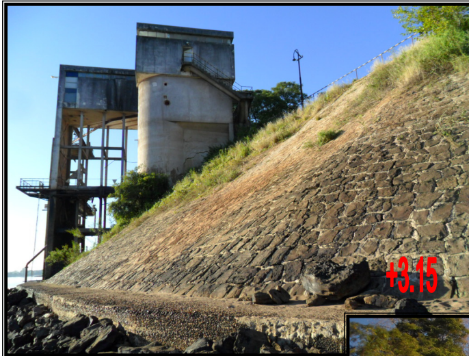
Foto 19-Recubrimiento Marginal con pequeñas deformaciones, sin presentar problemas serios. (orientación de fotografía Sureste)
