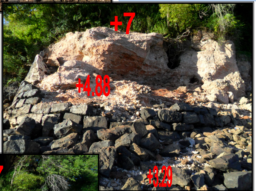
Foto 16- vista lateral del deterioro del espigón (orientación de fotografía Sureste)
