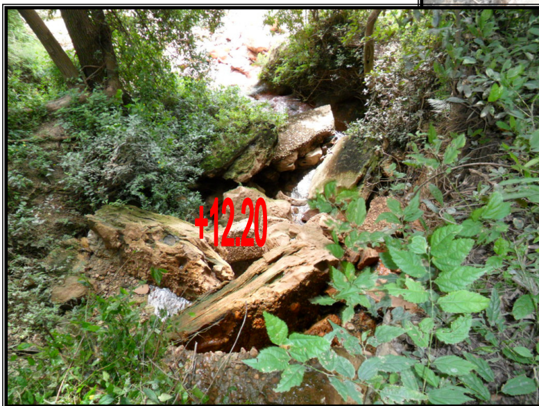
Foto 15 Rotura del extremo en la descarga como consecuencia de la erosión de su base.
