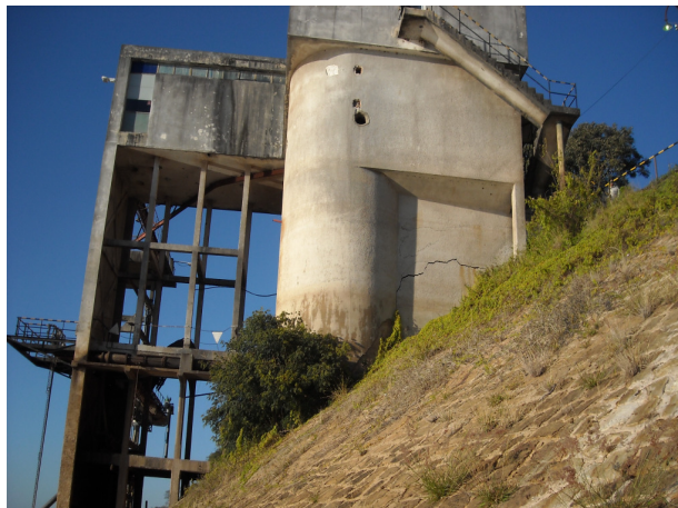
Sala de Maquinas+Torre de toma
