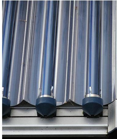
Figura 37: Colector solar con tubos de vacío - extremo de los tubos de vacío, junto con las aletas de aluminio.
