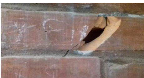
Figura 18: Muro de ladrillo cerámico hueco.
