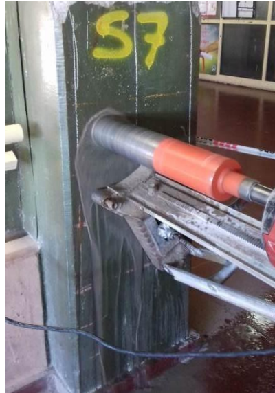
Figura 7: Proceso de extracción de testigos de hormigón.
