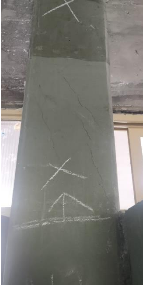
Daños producidos por el efecto de columna corta.
