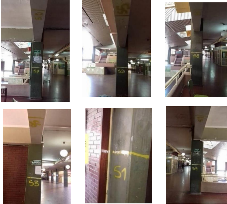
Figura 2: Sectores seleccionados para la ejecución de ensayos de caracterización de materiales
