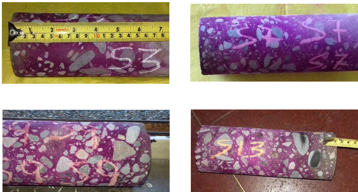
Figura 11: Determinación del frente de carbonatación en testigos extraídos.
