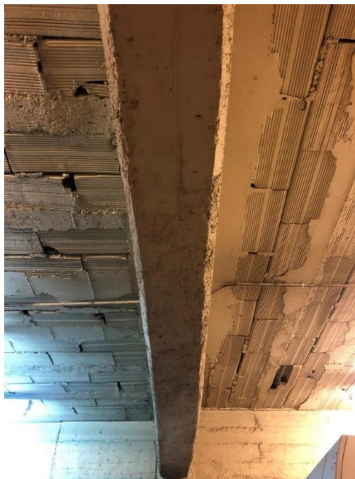
Imagen 2.4. Foto de apreciación del estado de una de las vigas en el SS
