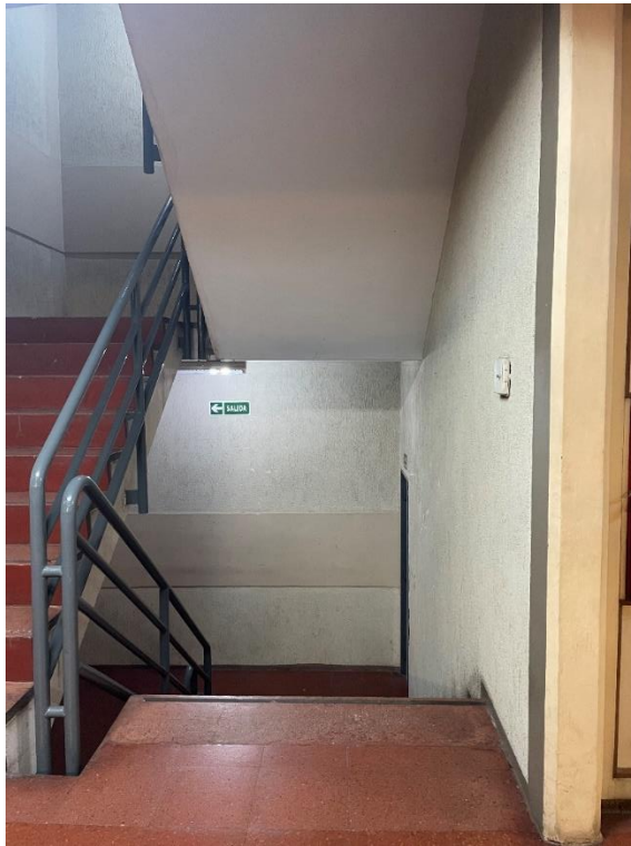
Imagen 2.12. Toma desde pasillo principal, se observan escaleras de acceso y descanso con acceso a baños (hacia la derecha, sentido Oeste)
