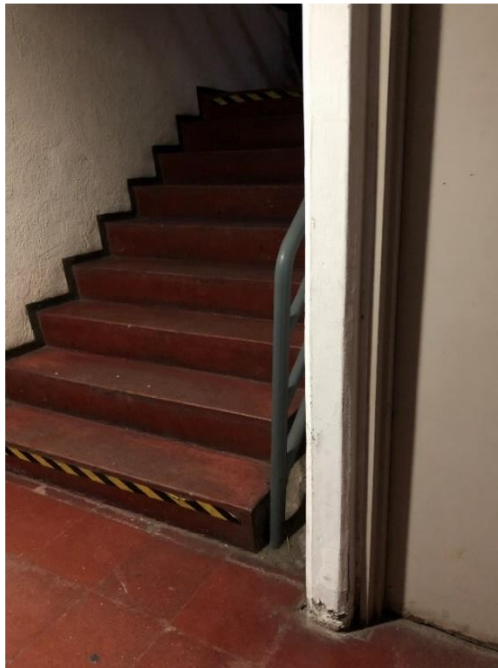
Imagen 2.2. Escalera de acceso al Primer Subsuelo
