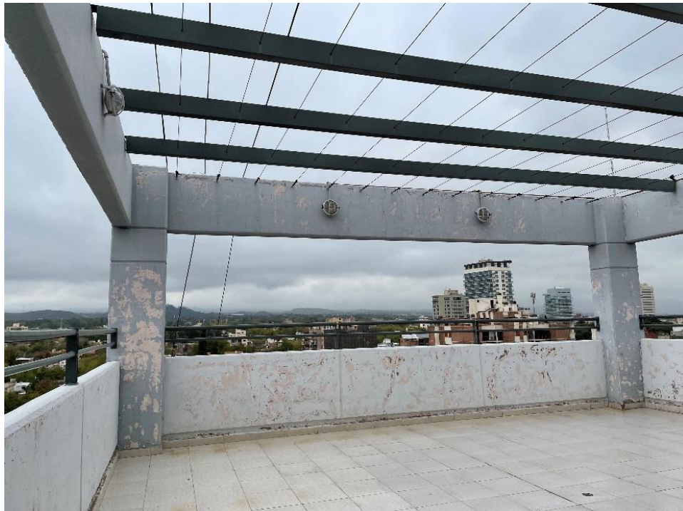
Imagen 2.15. Terraza del lado Oeste
