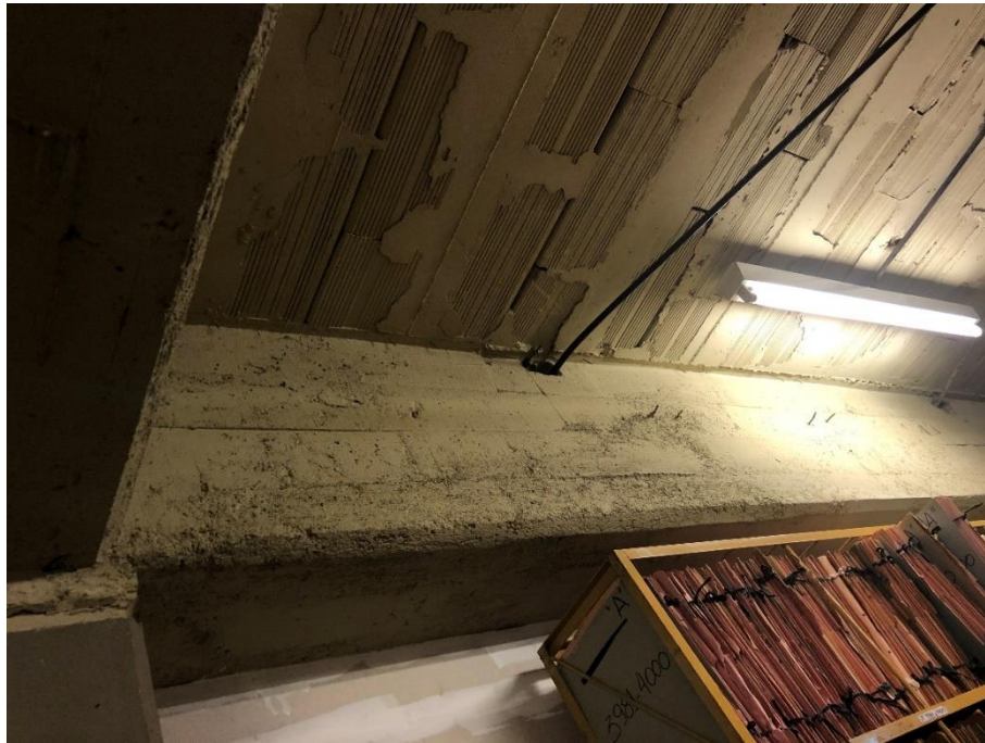
Imagen 2.3. Foto representativa del estado de los elementos estructurales en SS
